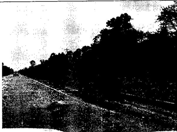
Fotografía 7 baches, sedimentos en los espaldones y cunetas, vegetación en márgenes laterales
