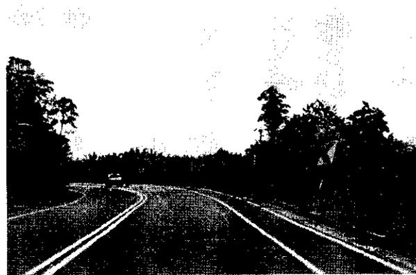
Fotografía 12 Señalización vertical desalineada, falta de mantenimiento
