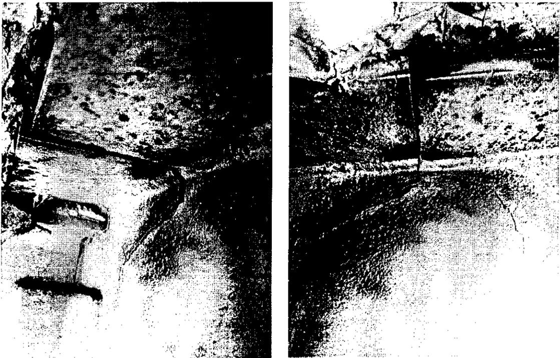
c.- **Corrosión:** Existe un avanzado estado de corrosión en el alma de una de las vigas transversales de arranque del puente tipo arco.
