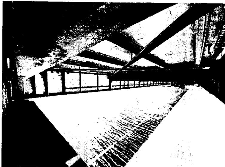
d.- Desplazamiento de los elementos de apoyo: En el extremo del puente donde los elementos de apoyo funcionan como empotrados han sufrido un importante desplazamiento que visiblemente se puede apreciar.
