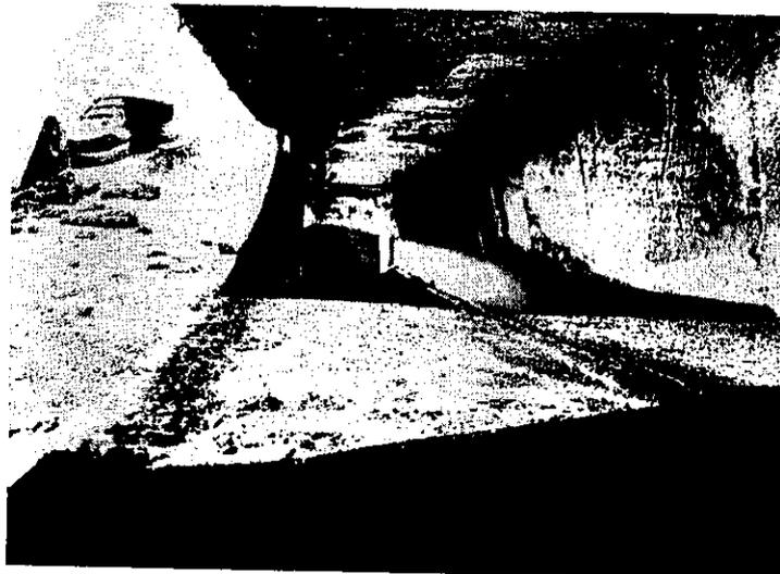
b.- **Grietas en el metal base:** Están localizadas en la parte superior del alma de las vigas transversales del puente. Algunas de ellas siguen la orientación de la grieta del patín superior.
