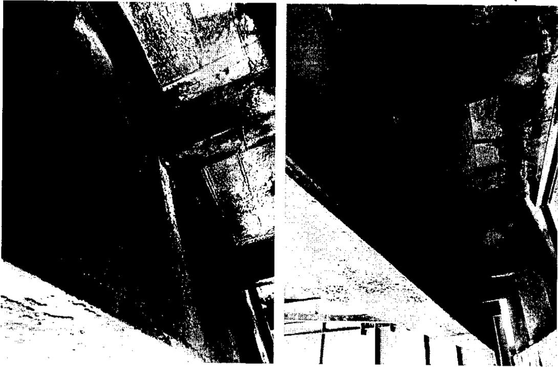
También se puede apreciar corrosión en otros elementos del puente, aunque en menor grado.
