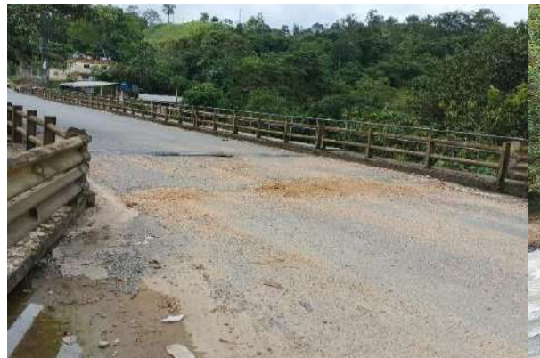
Problemas de drenaje y fallas en el pavimento
