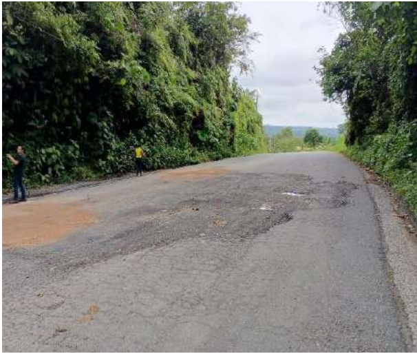
Problemas de drenaje y fallas en el pavimento
