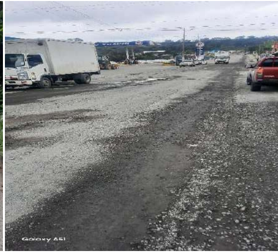
Problemas de drenaje y fallas en el pavimento
