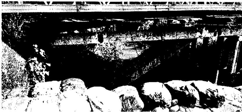
Colapso de la Viga Central del Puente existente
