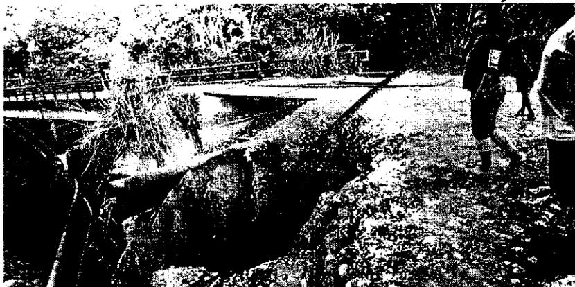
Socavamiento del material detrás del estribo derecho del Puente Chiripuno
