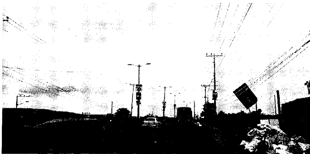
Inicio del proyecto abscisa 13+200 - Entrada al Barrio Monte Sinaí
