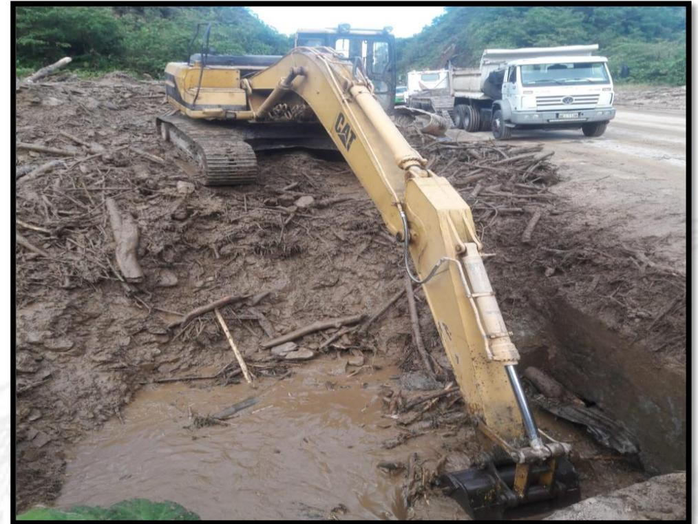
**Limpeza de las alcantarillas con azolvamiento a lo largo de la Red Vial Estatal de Napo.**
