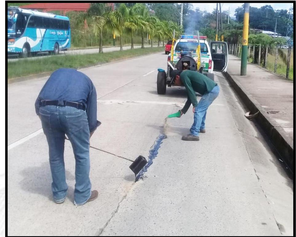
Sello de fisuras en el pavimento rígido del tramo de vía Tena – Archidona.
