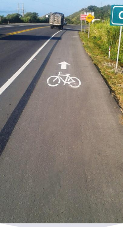
Cuentan con un carril acondicionado para la circulación exclusiva de bicicletas separado del tráfico vehicular mediante señalización (letreros y demarcaciones) y que es parte de la calzada. En este tipo de ciclovías el ancho mínimo es de 1.20 y el máximo es de 2.50.
