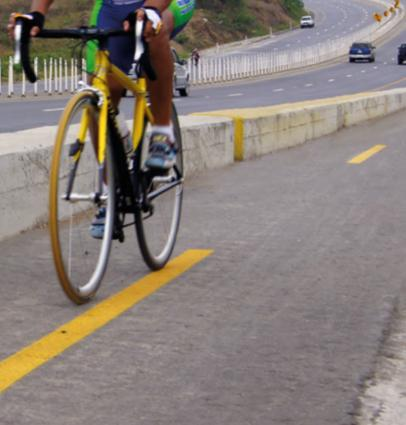
De uso exclusivo para bicicletas, se encuentra apartada de la circulación del tránsito motorizado, sin embargo, pueden ser diseñadas dentro del trazado de la vía. Cuando es unidireccional, varía entre 1.20 y 1.50 metros y si es bidireccional, de 2.50 y 3 m.
