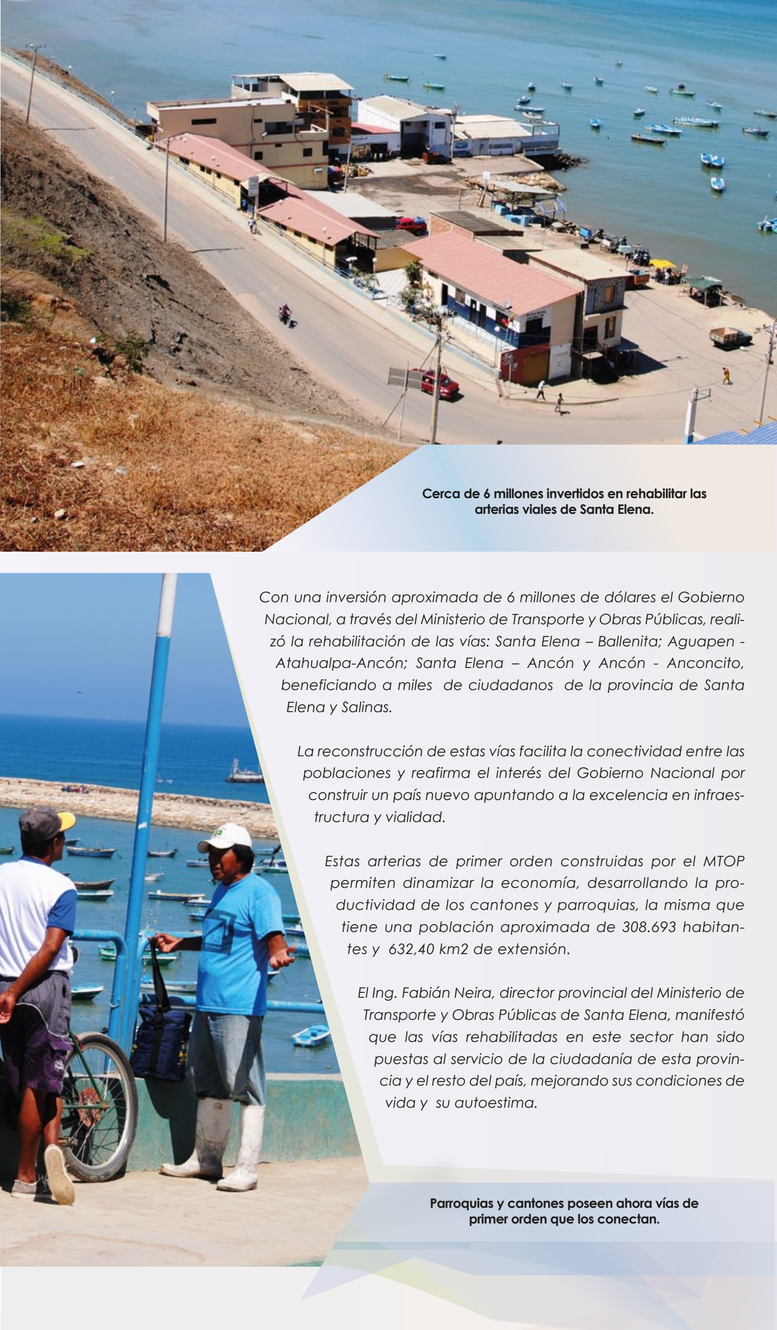
Cerca de 6 millones invertidos en rehabilitar las arterias viales de Santa Elena.
