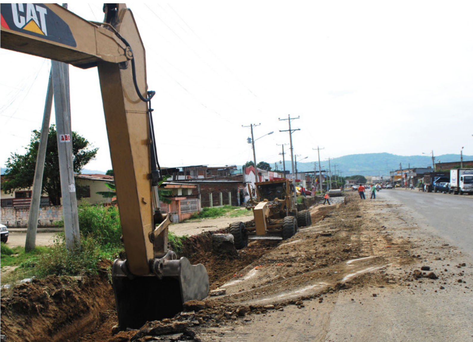
Trabajos de remoción de tierra para colocar las tuberías del alcantarillado.
