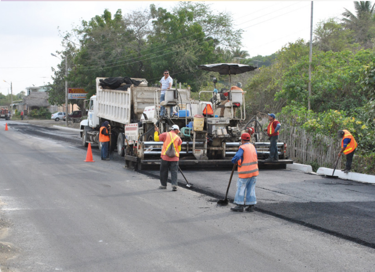
Asfaltado de la carretera a nivel de pavimento flexible.
