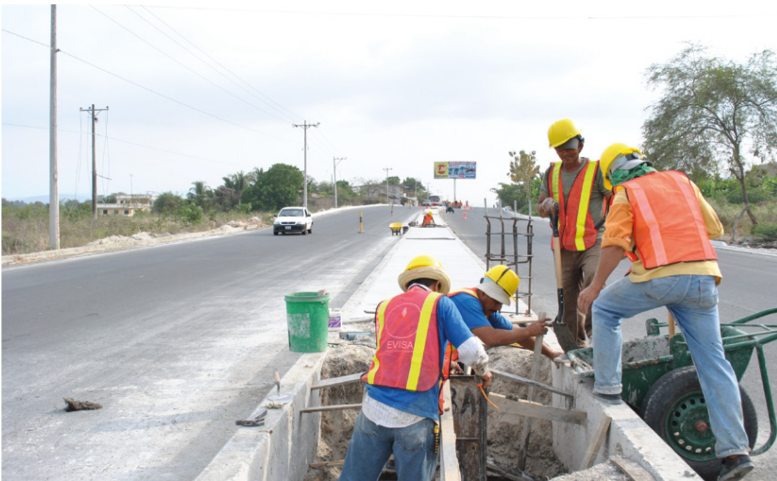
Trabajos en el parterre central para colocar luminarias.
