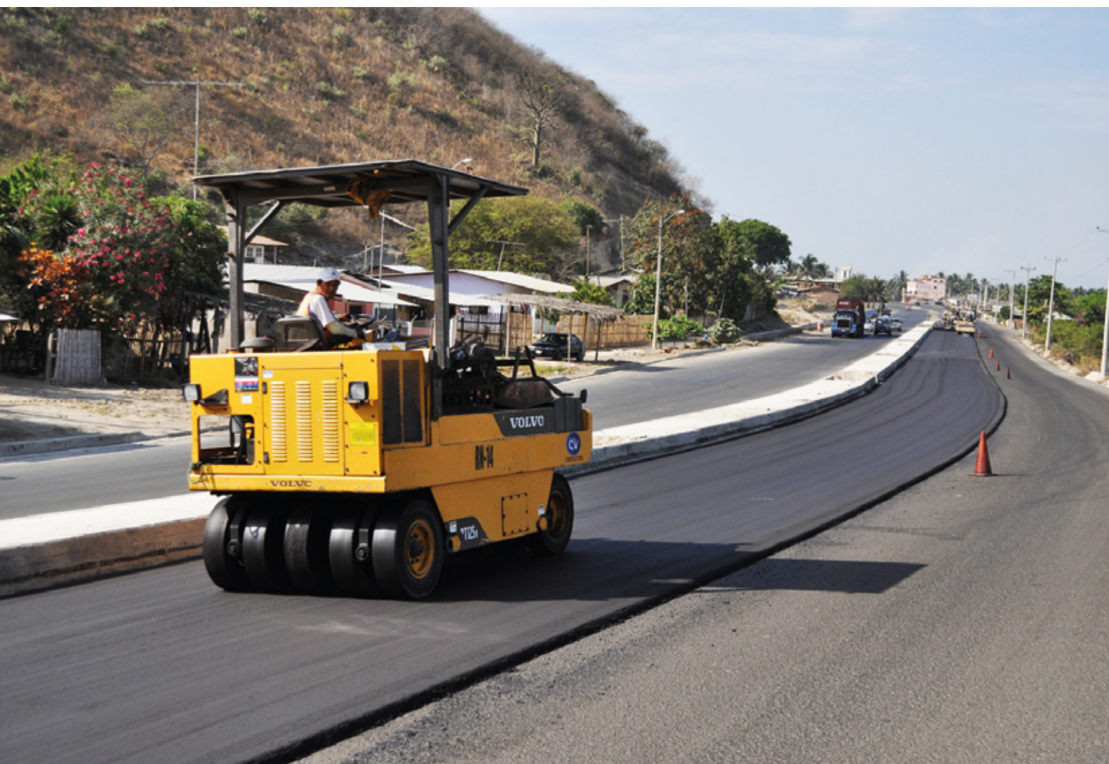
Trabajos de compactación de la capa de asfalto.
