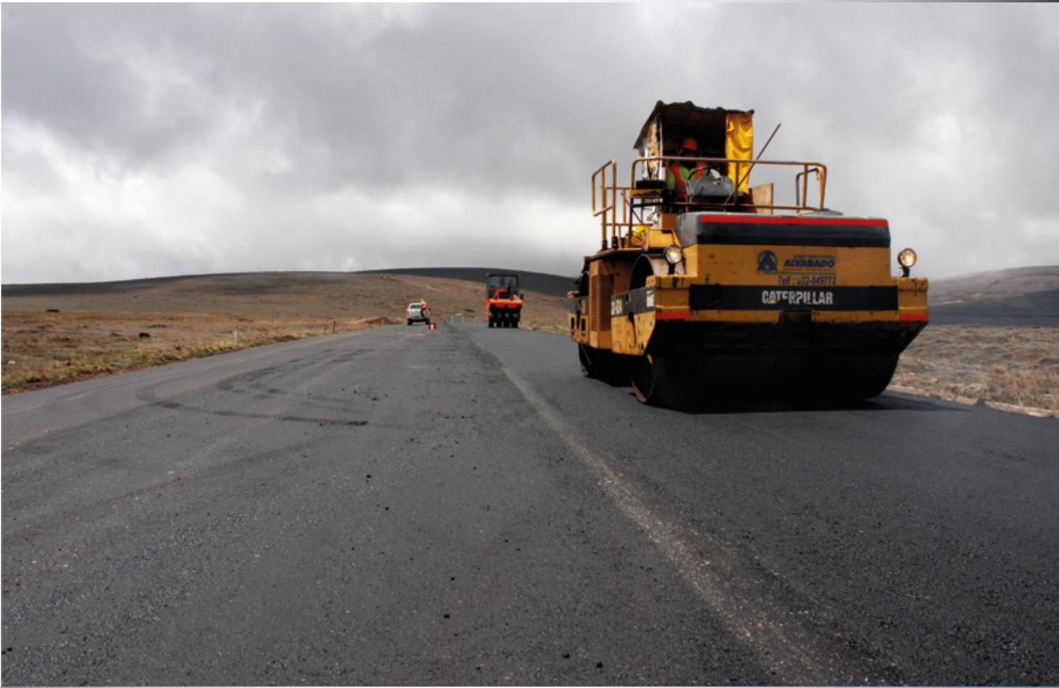
*Colocación de pavimento flexible a lo largo de la vía*
