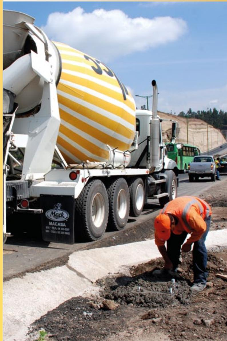
*Fundición de base para la colocación de señalización horizontal.*
