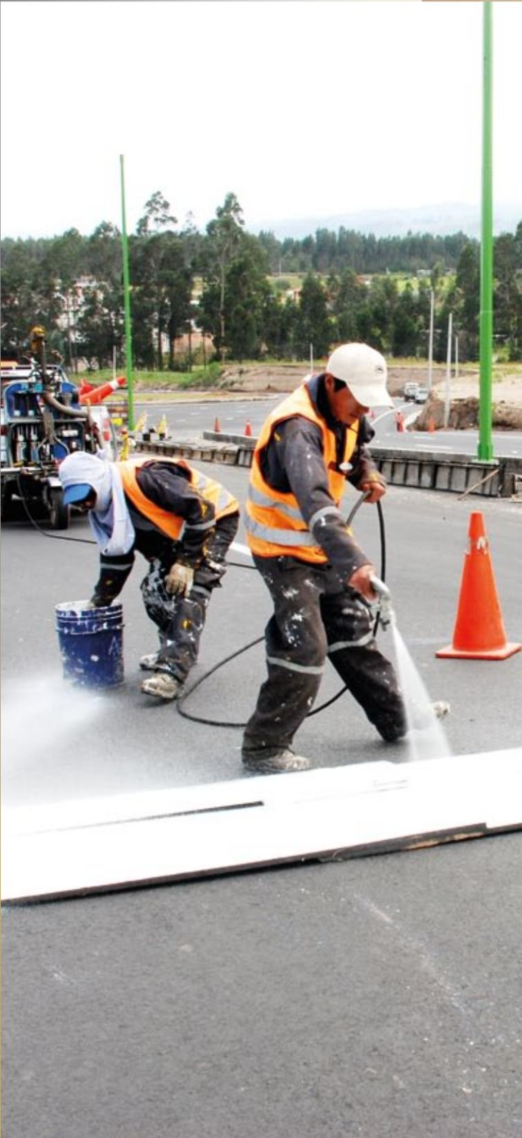
*Trabajos de señalización con pintura termoplástica en la vía.*
