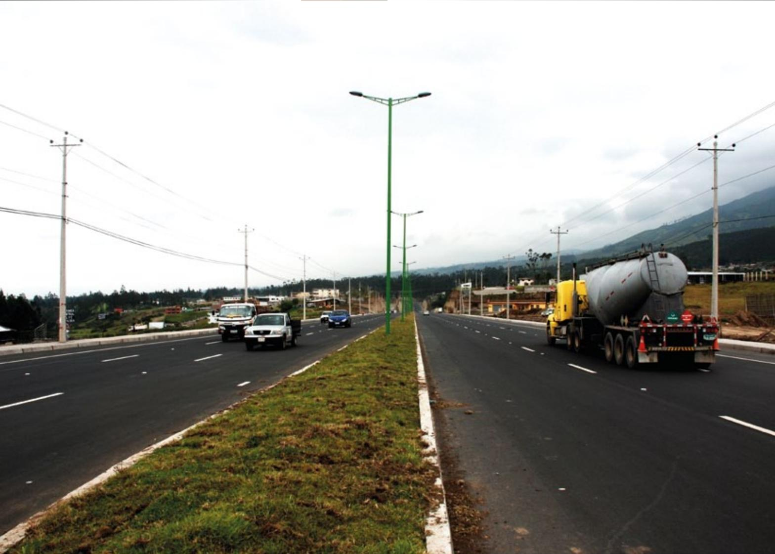
*La vía se encuentra construida a nivel de asfalto flexible con seis carriles que soportará incluso el tráfico pesado.*
