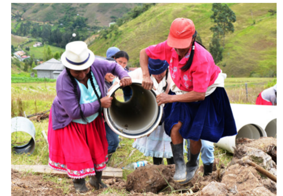
Comunidad aporta en los trabajos del Canal de río San Francisco.
