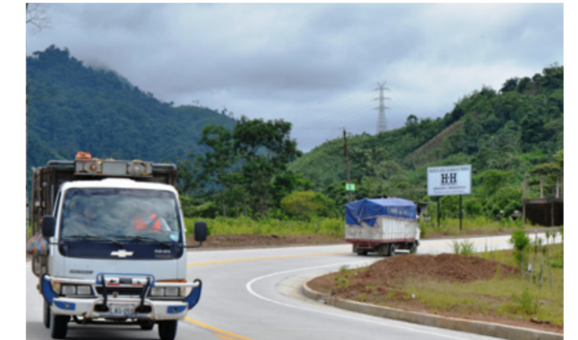
Beneficiarios facilitaron la ubicación de escombreras en la carretera Zhud - Cochancay - El Triunfo.
