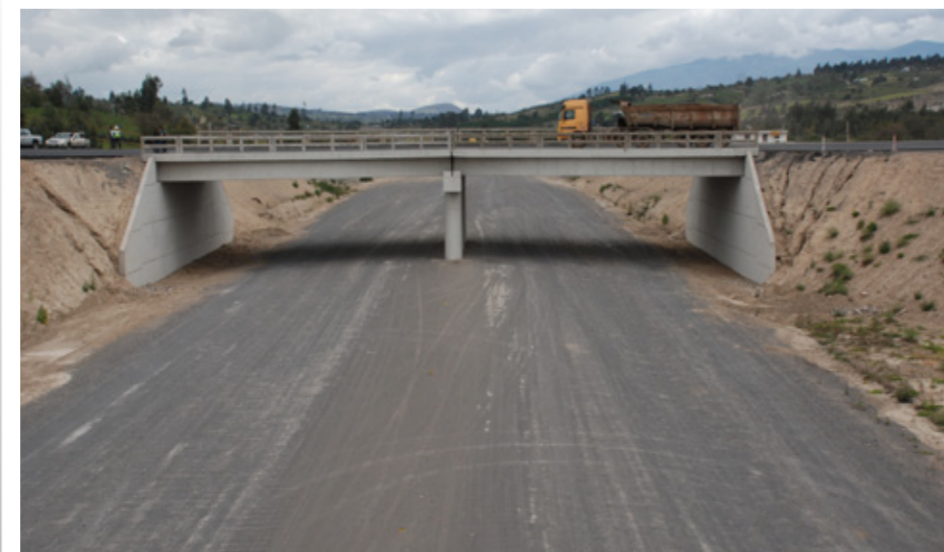
Alrededor de 11 pasos laterales están en construcción, entre ellos el de Latacunga, Manta y Yantzaza, entre otros.
