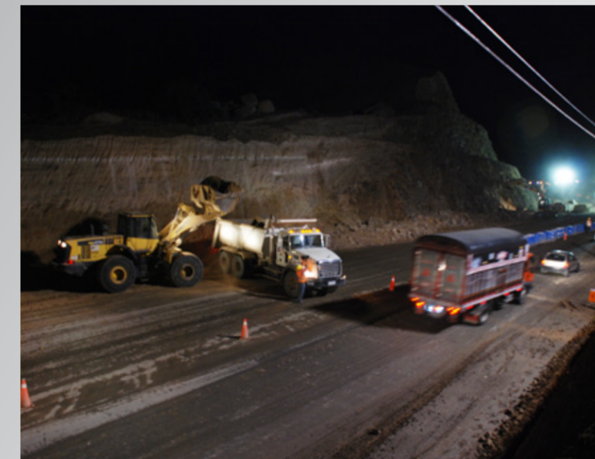
Trabajos nocturnos en el sector de Ambuquí
