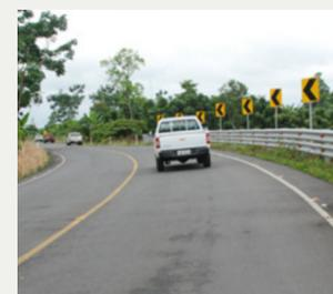
La nueva estructura incluye señalización horizontal y vertical, y cunetas laterales.
