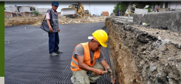
Obrero colocando elementos de fijación de geotextil
