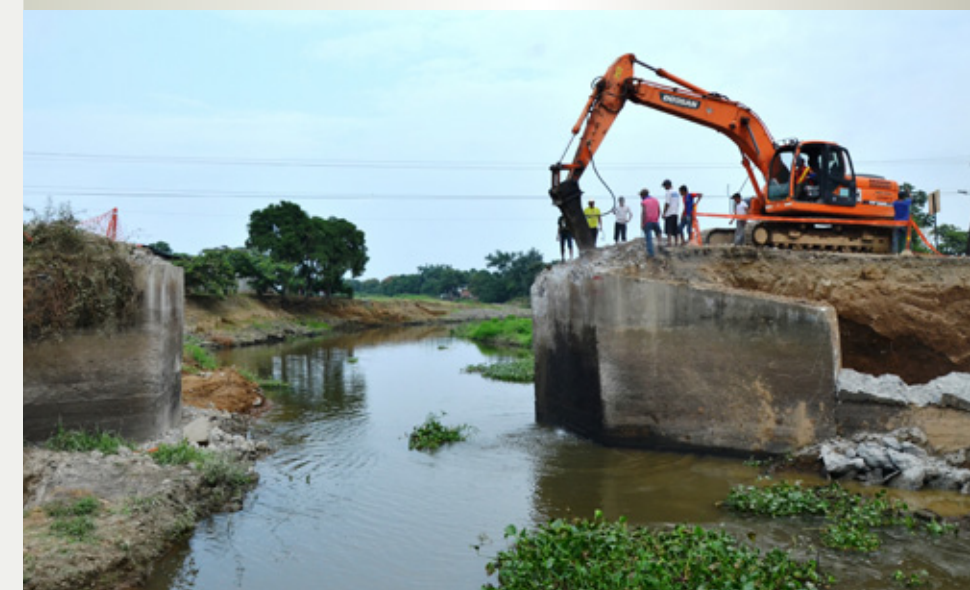
Se reconstruirá tres puentes en el cantón para complementar la obra: puente sobre el estero Cañafistola, puente sobre el río Pueblo Viejo y puente sobre el río Arenal.
