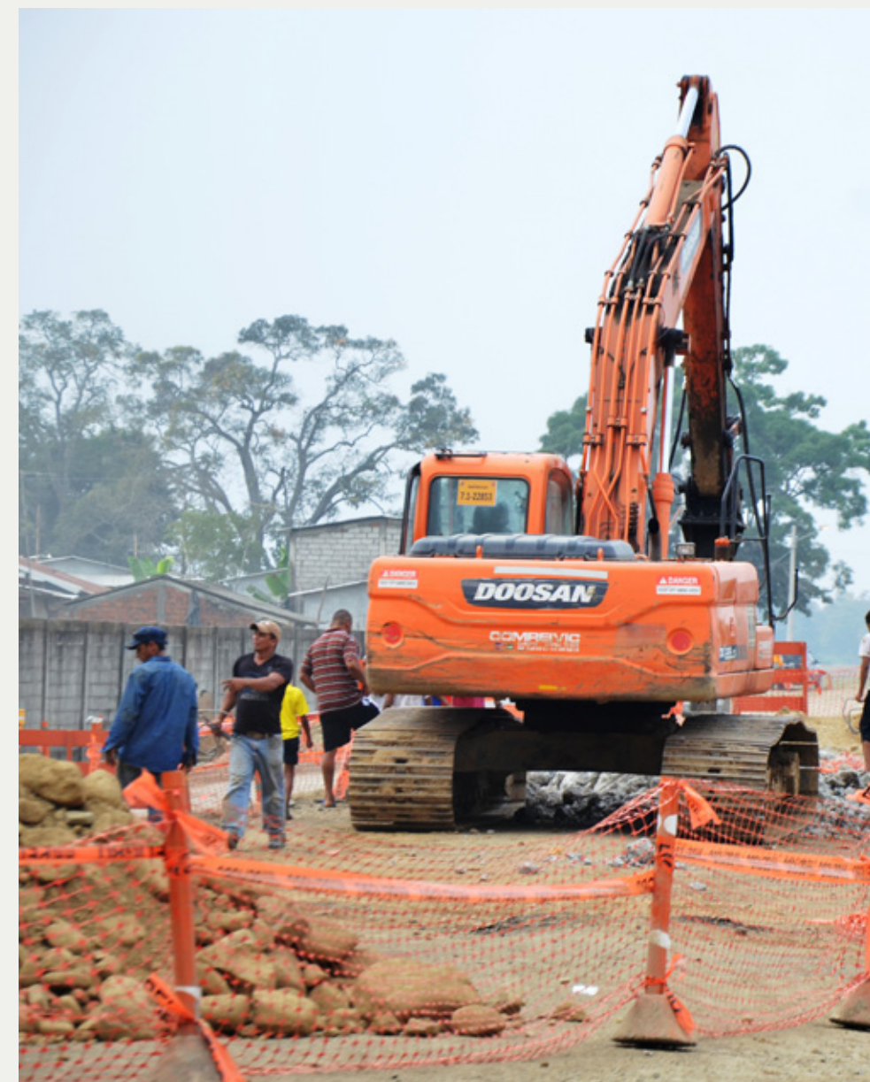
Los trabajos se efectúan en la capa subrasante a lo largo de la vía para preparar el suelo antes de la colocación del pavimento.
