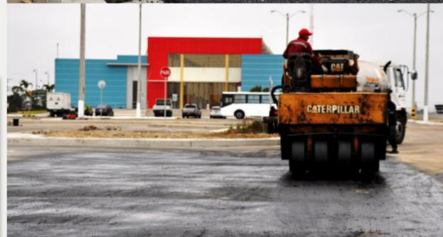
Colocación y compactación de asfalto en la vía de acceso de la nueva terminal terrestre
