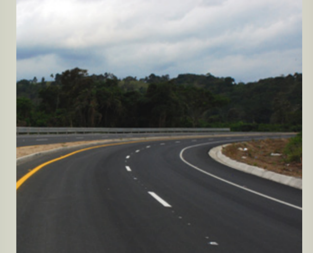
Las obras en el paso lateral de Tachina avanzan para enlazar a la provincia verde con la terminal aérea.
