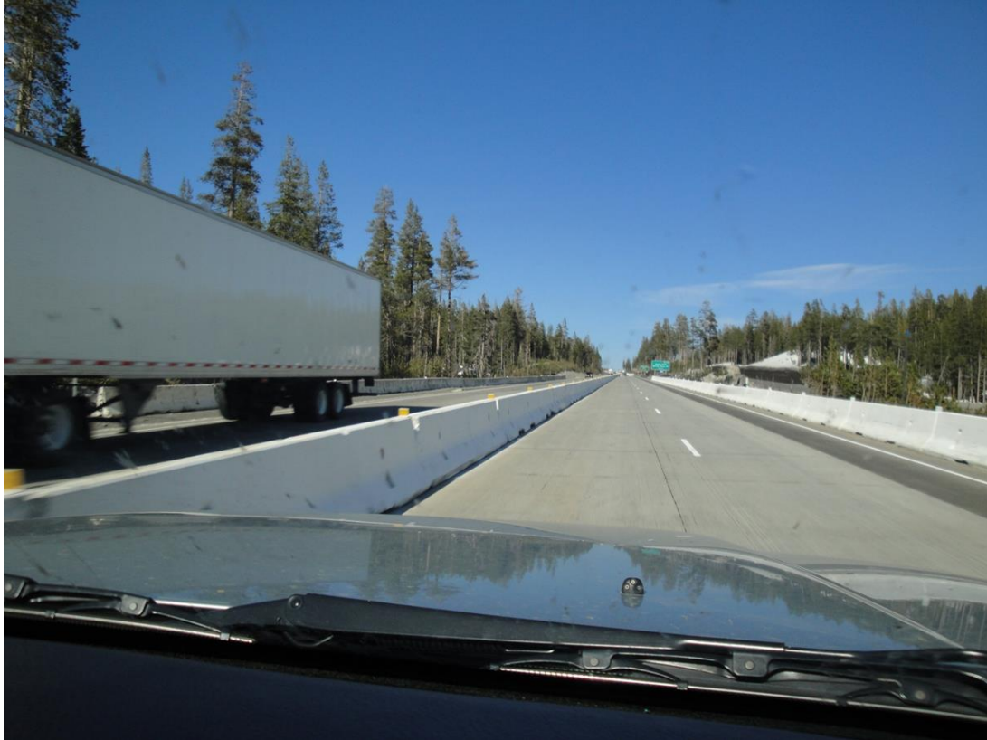
Figura 2A. 204-40. Ejemplos de cerramientos, con barreras Jersey a los costados de la Autopista
