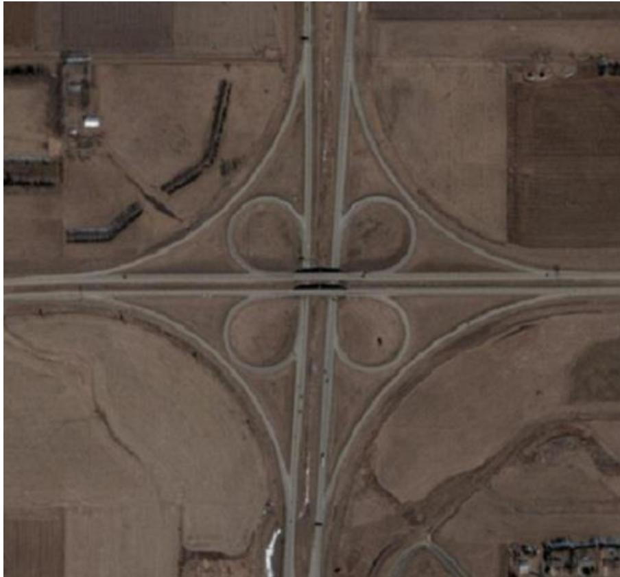
Figura 2A. 204-24 Intercambiadores de Trafico de 4 ramales. (Trébol)
