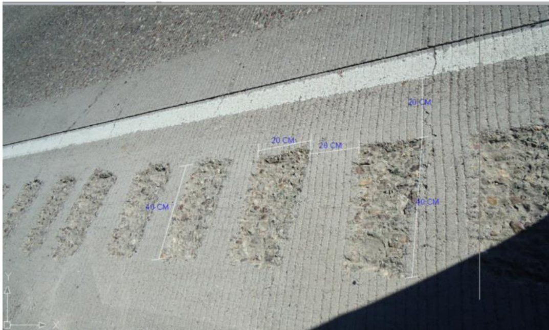
Figura 2A. 204-33 imágenes de dispositivos de seguridad, instalados en espaldones en las carreteras americanas
