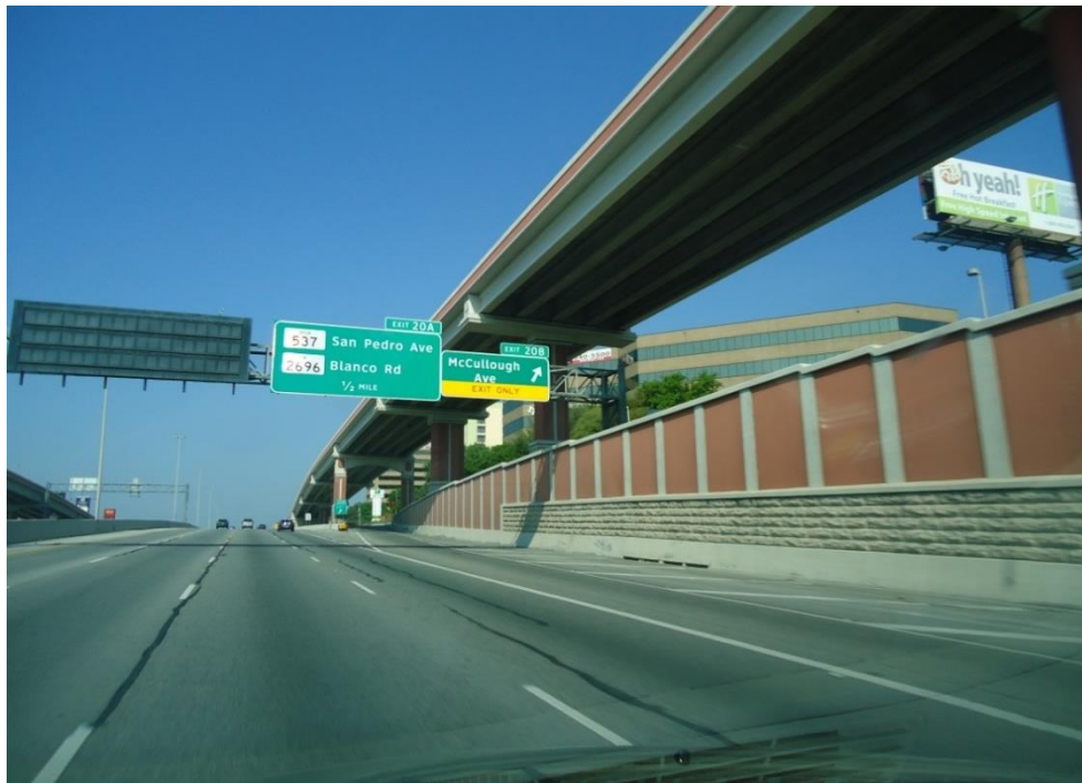
Figura 2A. 204-38. Ejemplos de cerramientos a los costados de la Autopista
