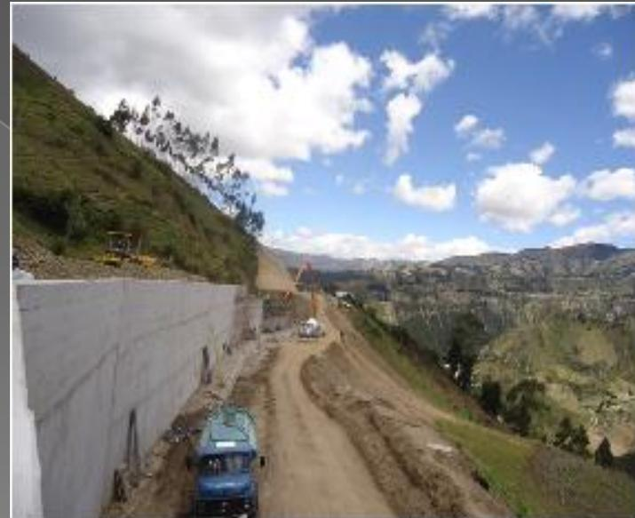
**Cunetas de hormigón simple (lado derecho) se encuentra construido hasta la abscisa 16+950, avance físico 90%, falta por ejecutar los sectores correspondientes al muro 15+800 y en la alcantarilla en la abscisa 2+540 hasta la abscisa 2+940 ( L=350**
