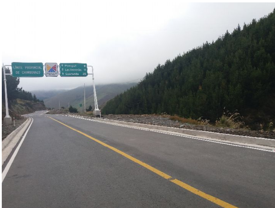
Fotografía: Carretera Guaranda – Las Herrerías – San Juan
