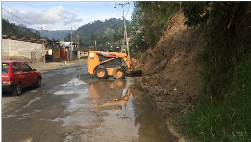
Fotografía: Minicargadora del MTOP Cañar, realizando limpieza de derrumbes, sector: Chacapamba.
