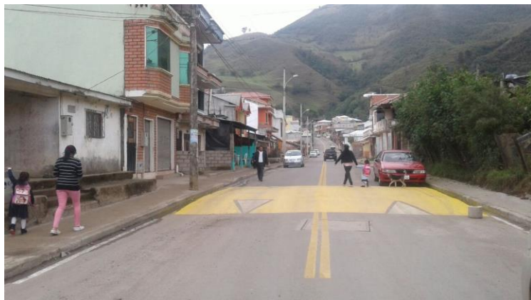
Fotografía: Acceso de vía Ducur - Gualleturo
