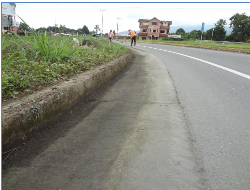
Fotografía: personal de la Contratista Hidalgo & Hidalgo, realizando trabajos de mantenimiento en la vía, sector La Troncal.
