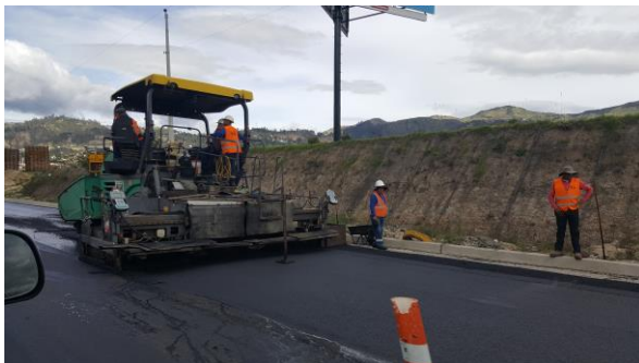
Colocación de Carpeta asfáltica,
