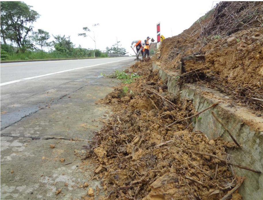
Fotografía: personal de limpieza realizando trabajos en la vía.
