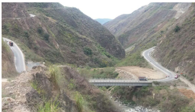
Fotografía: Puente de Hormigón sobre el río Cañar, Km 10+700.
