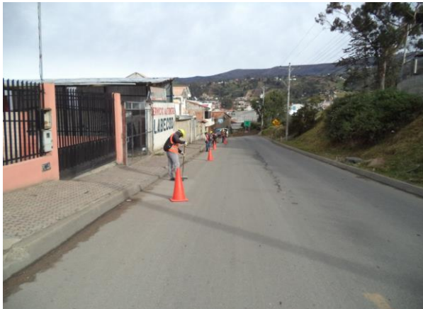
Personal obrero de la Contratista FOPECA, realizando trabajos de mantenimiento en la vía.
