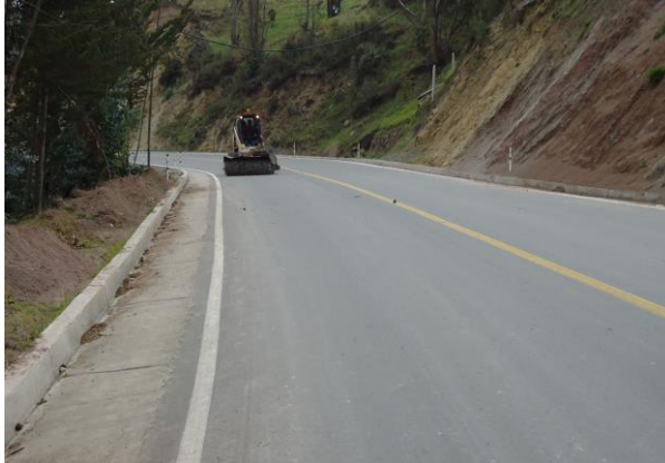
Equipo (Escoba mecánica) de la Contratista FOPECA, realizando trabajos de mantenimiento en la vía.
