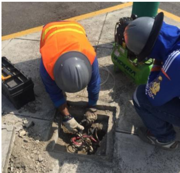
Fotografía: Mantenimiento de cajas de paso eléctricas
