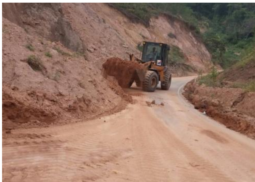
Fotografía: Maquinaria MTOP trabajando en limpieza de material
