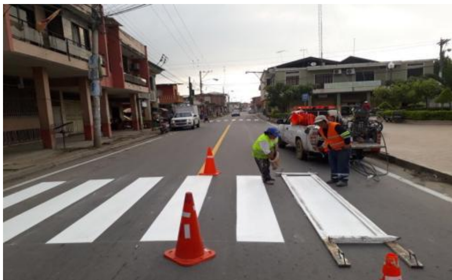
Fotografía: Trabajos de Señalización - Paso Cebra
