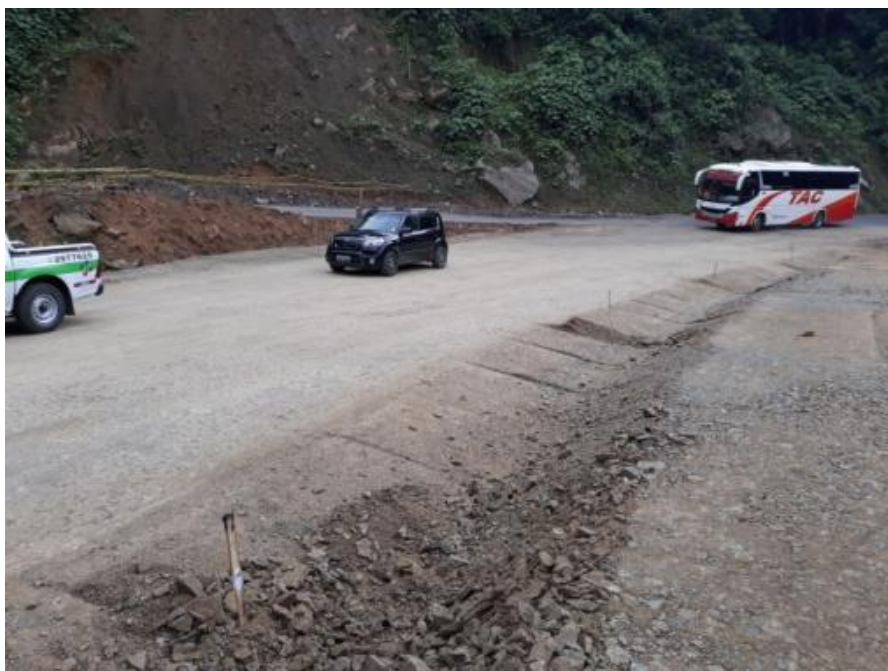
Fotografía: Paso rehabilitado sector Las Bateas
