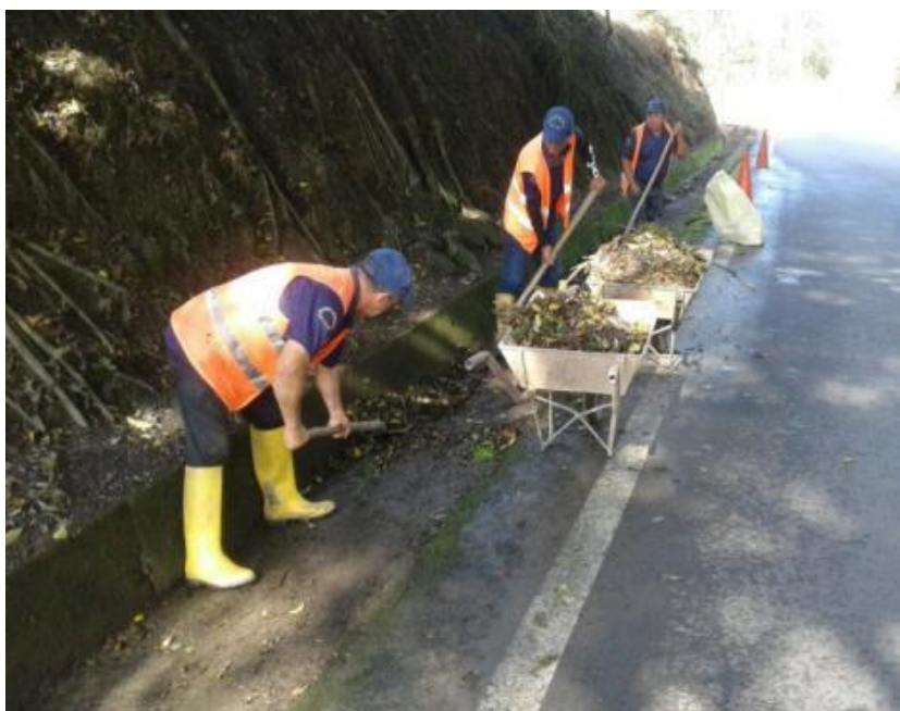
Fotografía: Personal de microempresas realizando trabajos en la vía.
