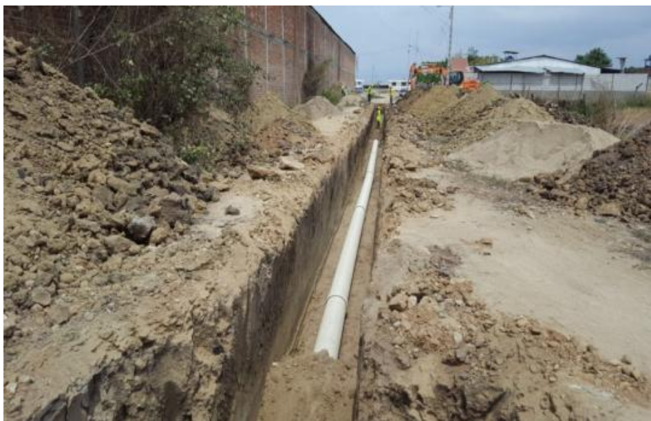
Fotografía: Instalación Tubería de PVC
