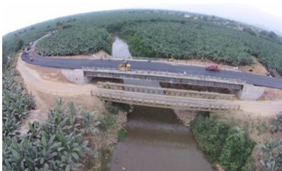
Fotografía: Puente sobre el río Buenavista
