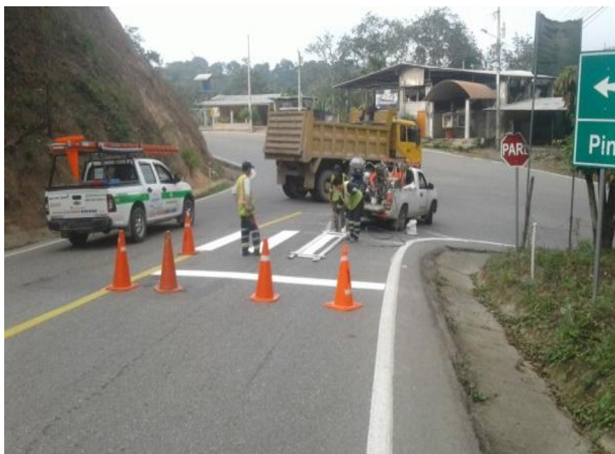
Fotografía: Trabajos de Señalización - Paso Cebra
