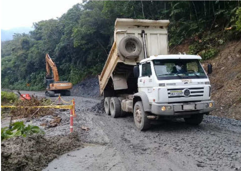
Fotografía: Mantenimiento Vial – Reposición de calzada
