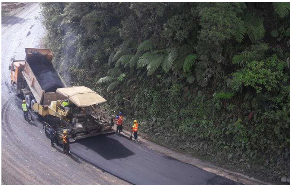
Fotografía: Colocación de Carpeta Asfáltica
