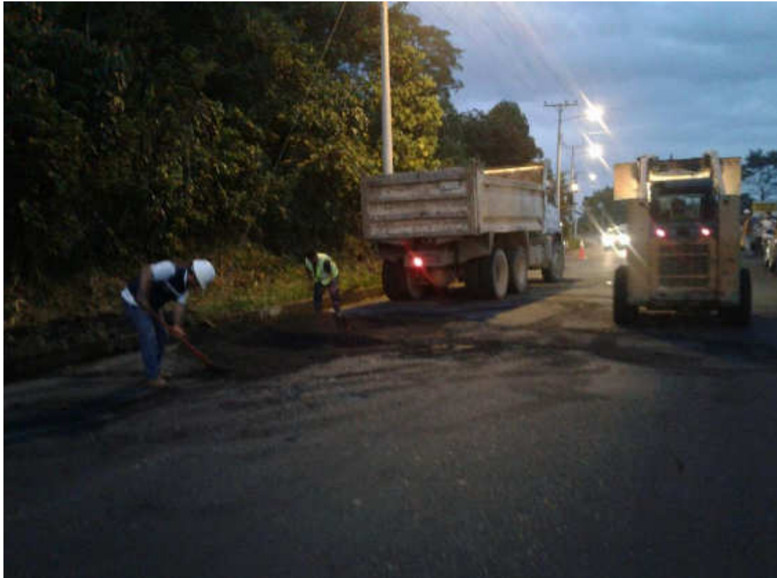
Fotografía: Bacheo vía Macas - Sucúa
