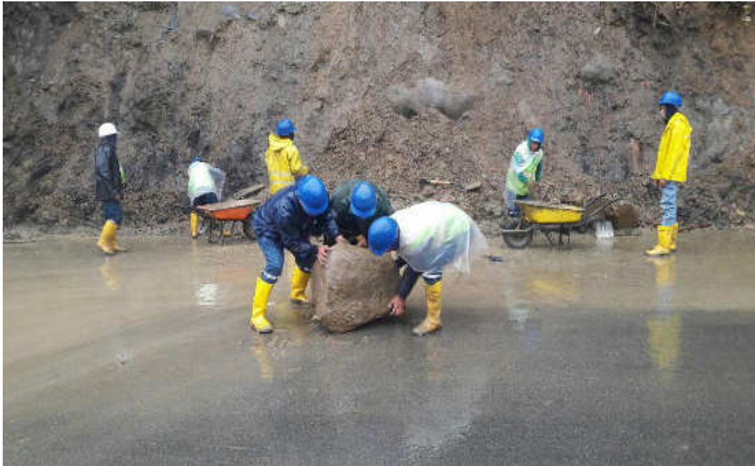
Fotografía: Asociación de Conservación Vial – Limpieza de derrumbes menores
