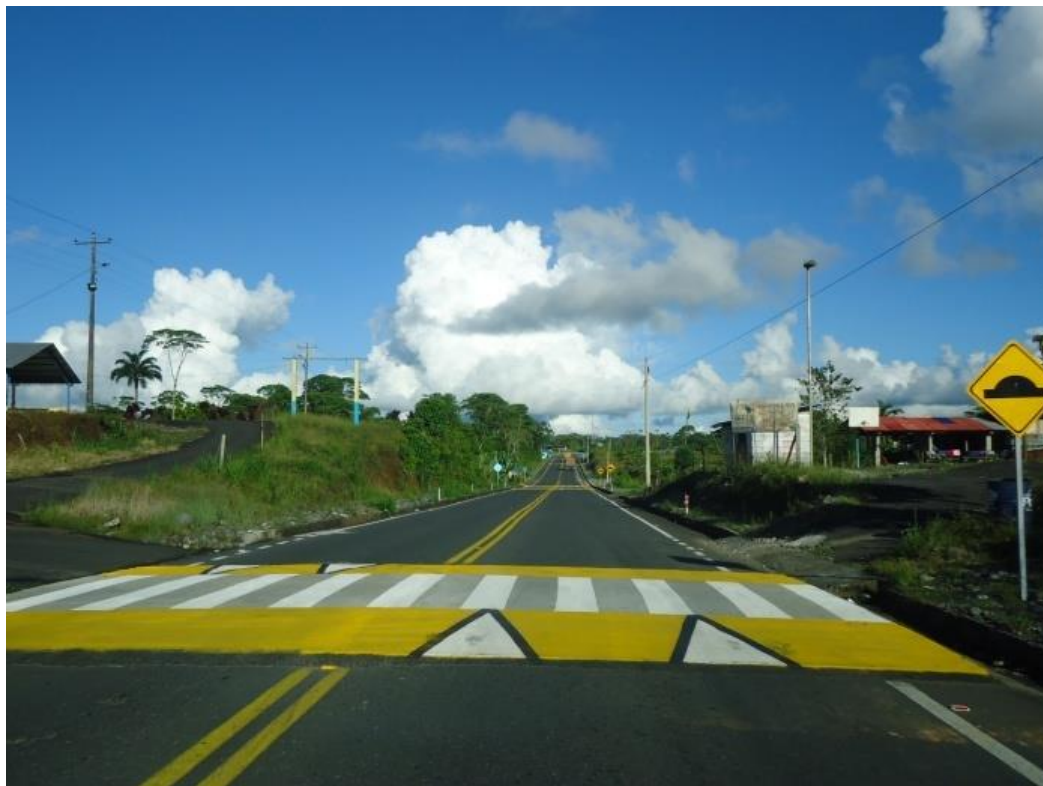
Fotografía: personal del MTOP realizando trabajos en la vía.
