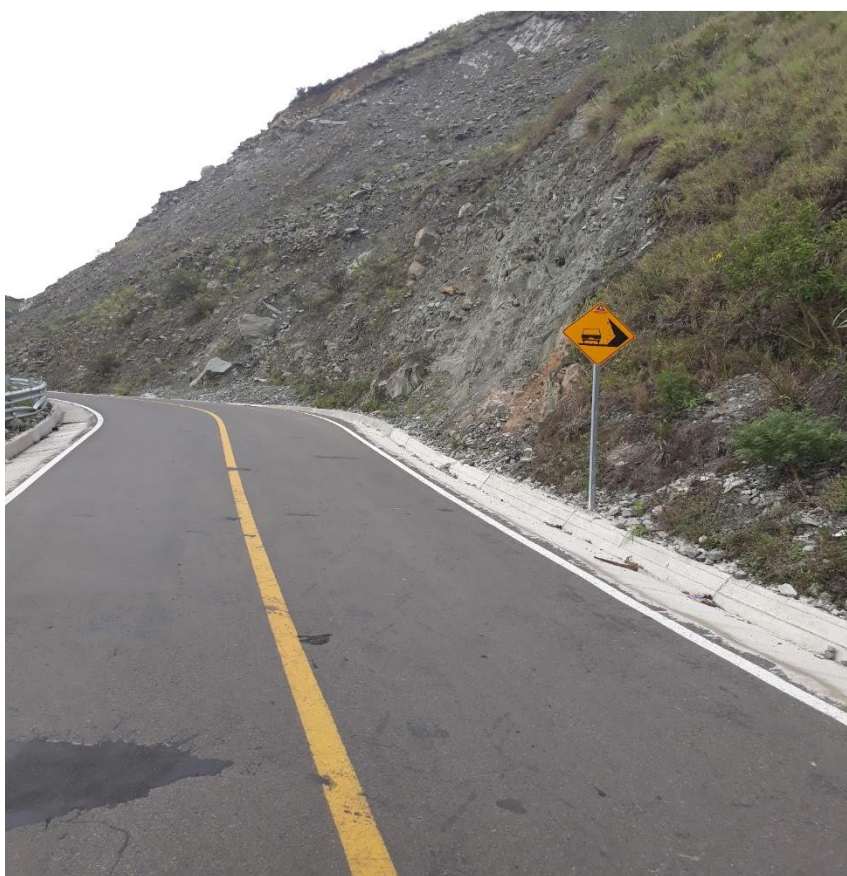
Foto 35 – Km 27+200 caída de materiales. Vista hacia Patate.
