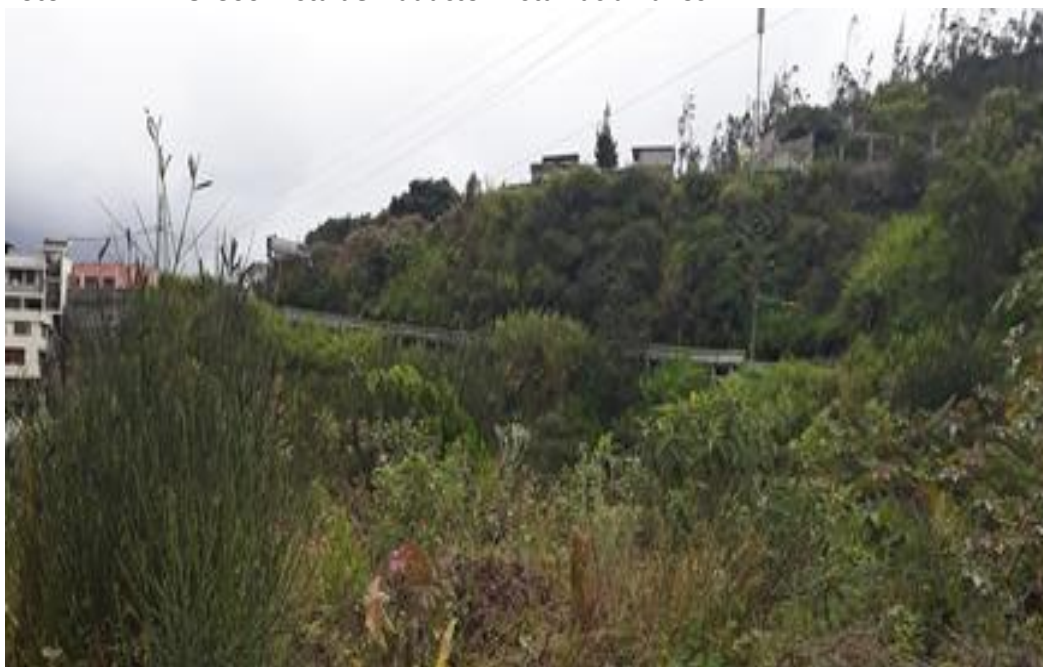
Foto 41 – Km 28+300 vista de viaducto. Vista hacia Baños
