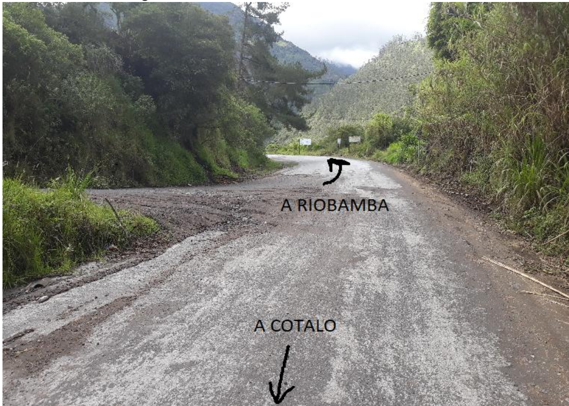
Foto 16 – Km 5+600 ingreso a Cotaló. Vista hacia Riobamba.
