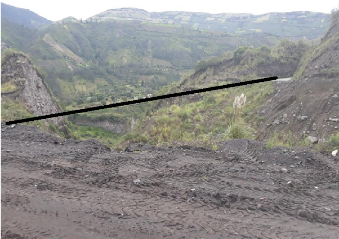
Foto 8 – 4+500 se requiere puente bailey de 120 m.
