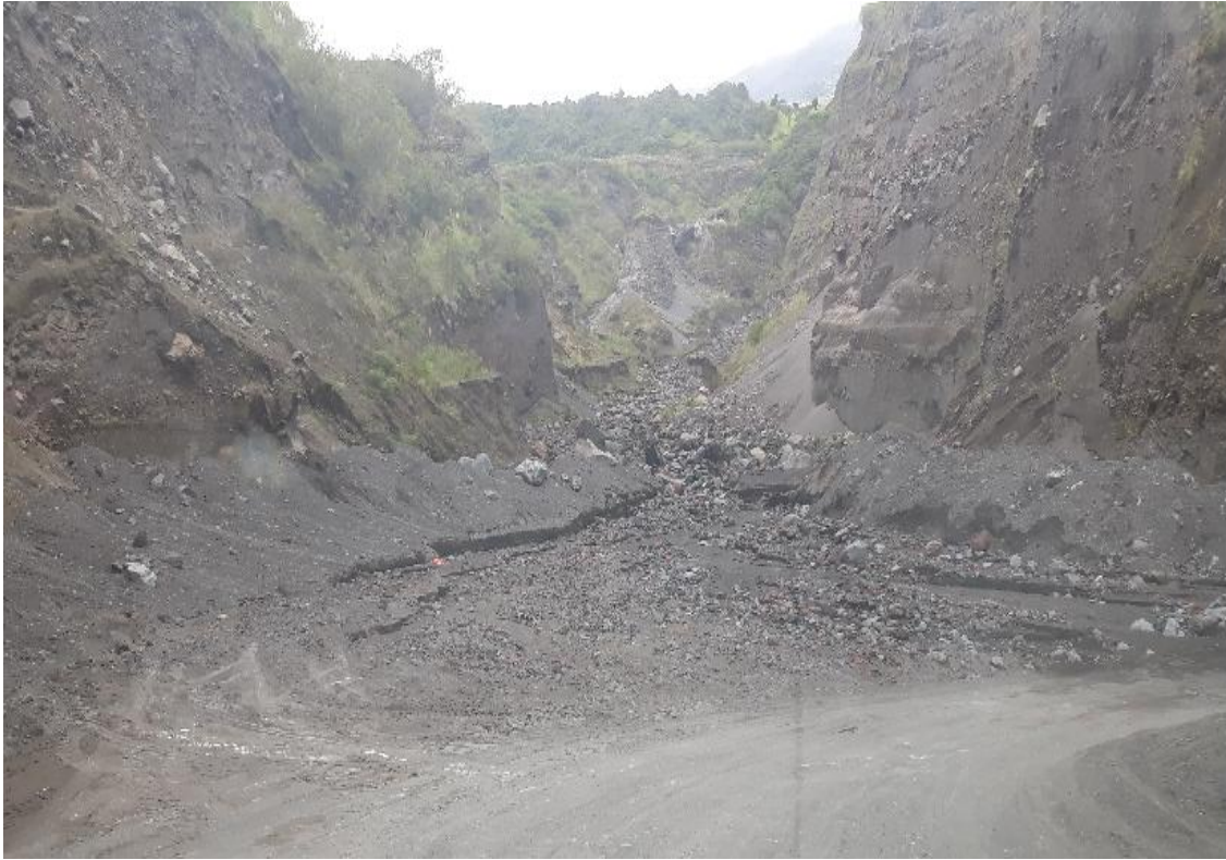
Foto 7 – Km 4+500 bajada de lahares. Desvío provisional .
