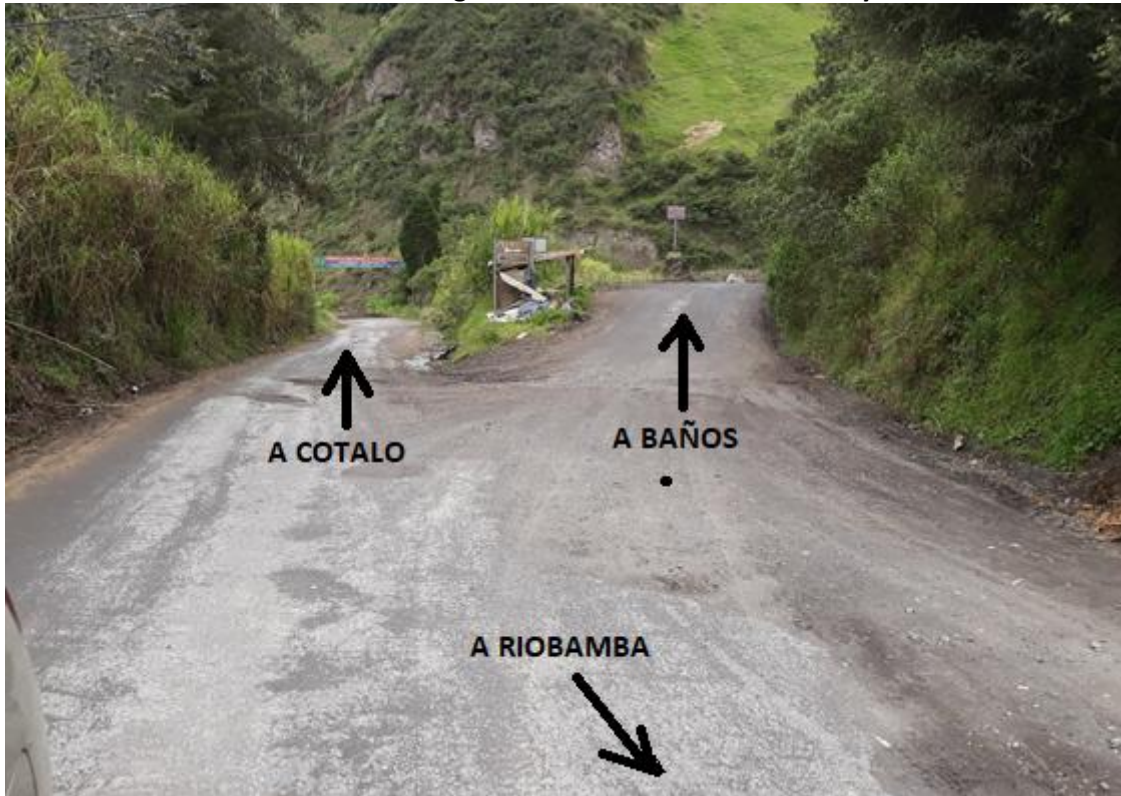
Foto 15 – Km 5+600 vía lateral de ingreso a Cotaló. Vista hacia Baños y Cotaló.
