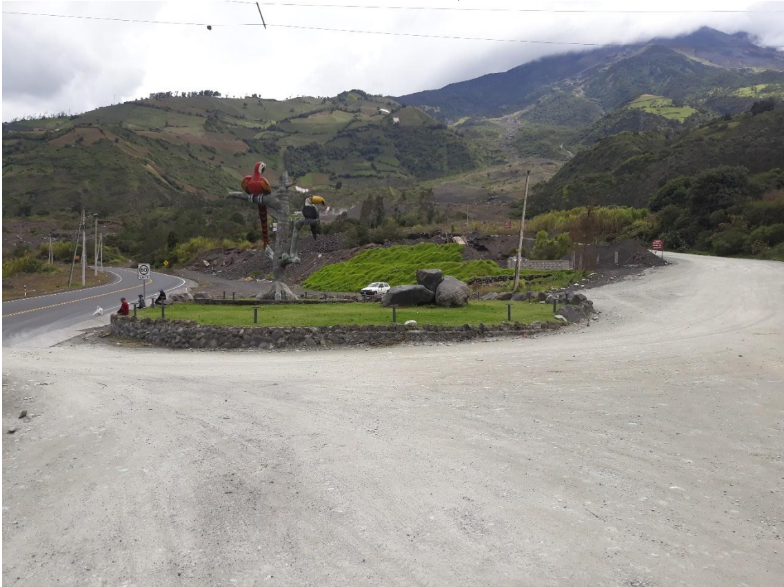
Foto 1 – Km 0+000 inicio de la vía . Sector Los Pájaros.
