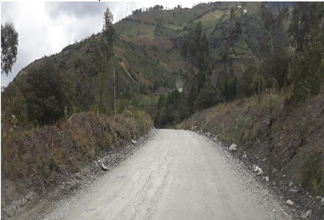
Foto 2 – Km 0+200 ascenso por vía lastrada.
