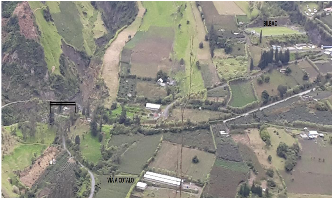
Foto 13 – Km 5+300 se requiere un puente bailey de 40 m. Vista desde la vía Cotaló – Cahujá.
