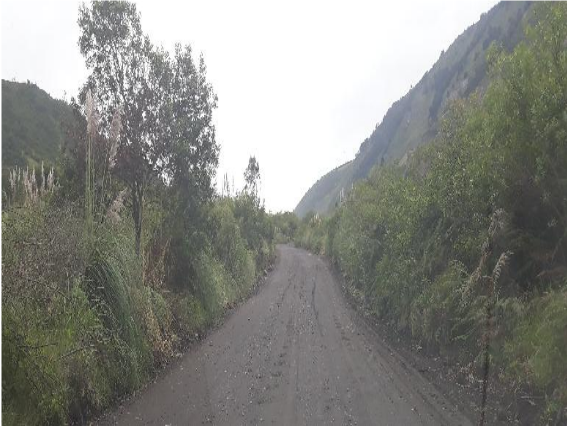
Foto 23 – Km 8+800 camino de desvío a nivel de material de mejoramiento.
