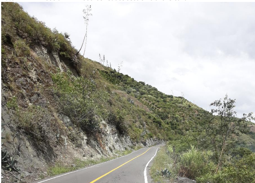
Foto 4 – Km 2+000 al km 4+600 se reduce sección transversal a 4 m.
