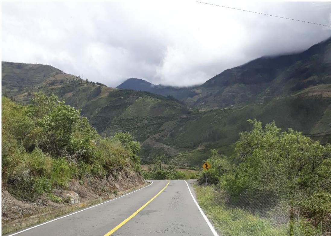
Foto 3 – Km 0+000 al km 1+800 sección transversal de 6 m.
