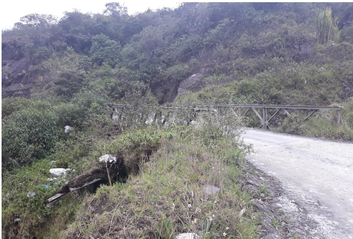
Foto 5 – Km 2+800 puente bailey de 12 m.
