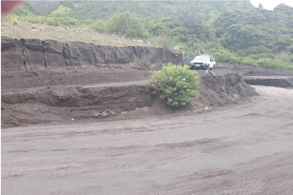
Foto 24 – Km 9+500 bajada de lahares. Se requiere la construcción de un puente bailey de 60 m. Paso provisional.
