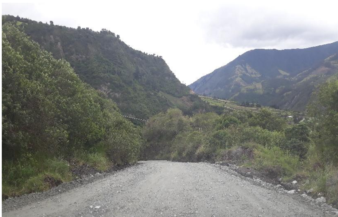
Foto 6 – Km 4+300 la vía a nivel de material de mejoramiento.
