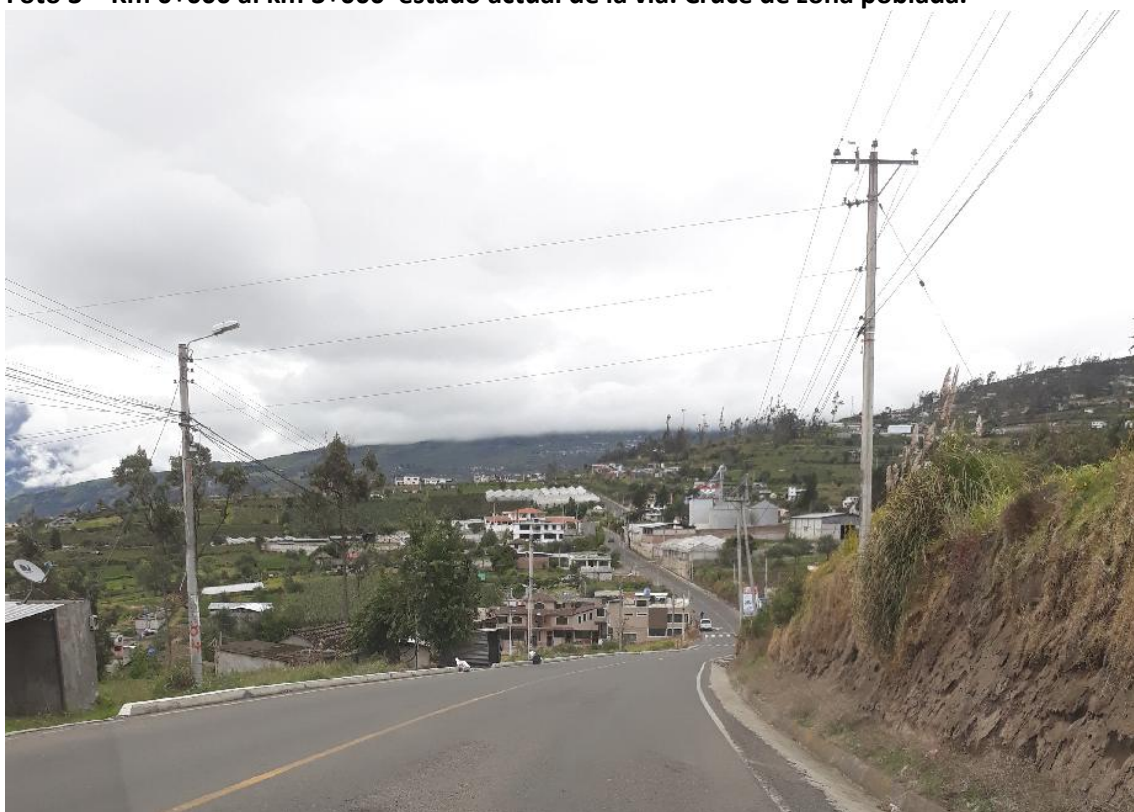
Foto 3 – Km 0+000 al km 3+000 estado actual de la vía. Cruce de zona poblada.
