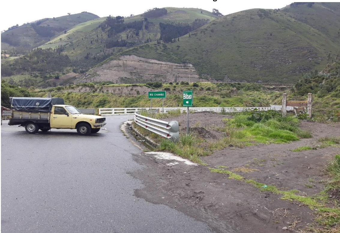
Foto 10 – Km 30+700 fin del tramo. Vista desde la vía antigua a Baños.
