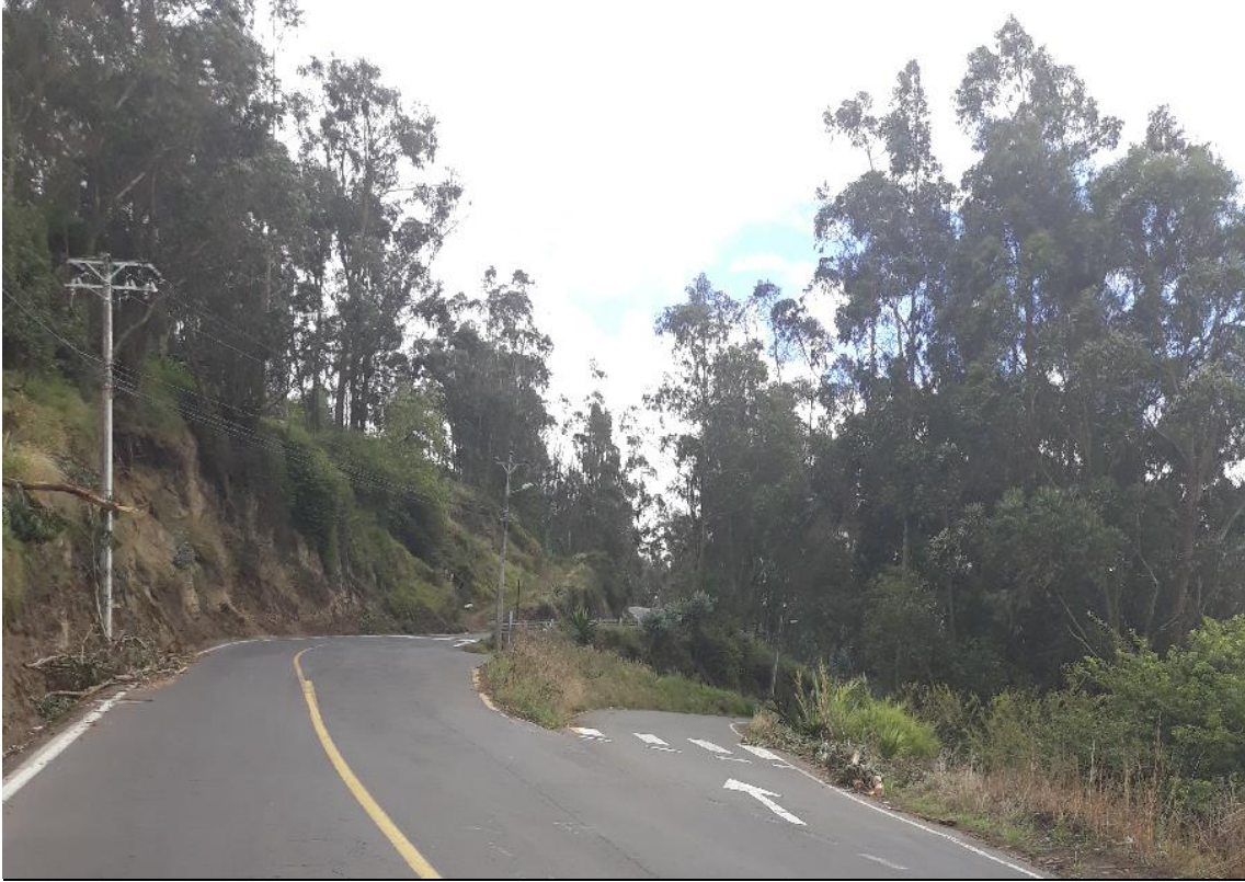
Foto 5 – Km 4+900 vía hacia el Corte. Vista hacia Pelileo.
