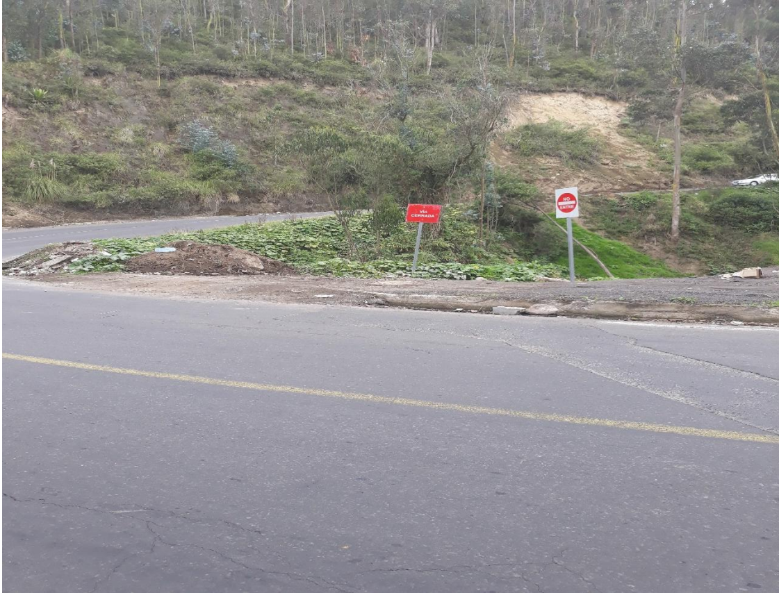
Foto 7 – Km 5+800 curva cerrada. Vista hacia Pelileo.
