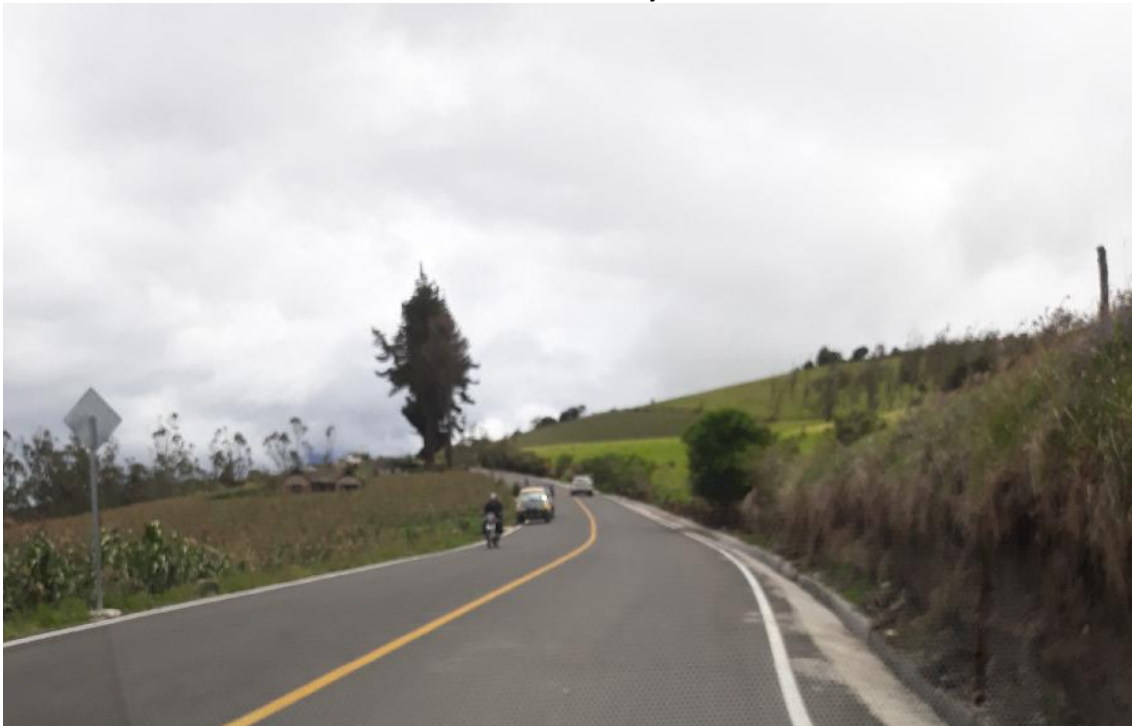
Foto 8 – Km 6+900 al km 9+500 sección transversal y estado actual de la vía.
