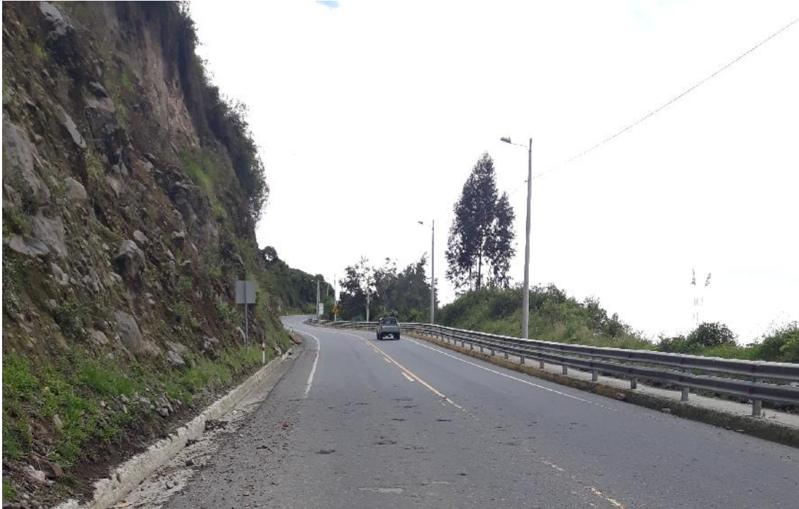
Foto 9 – Km 12+800 estado actual general de la vía. Vista hacia Pelileo.
