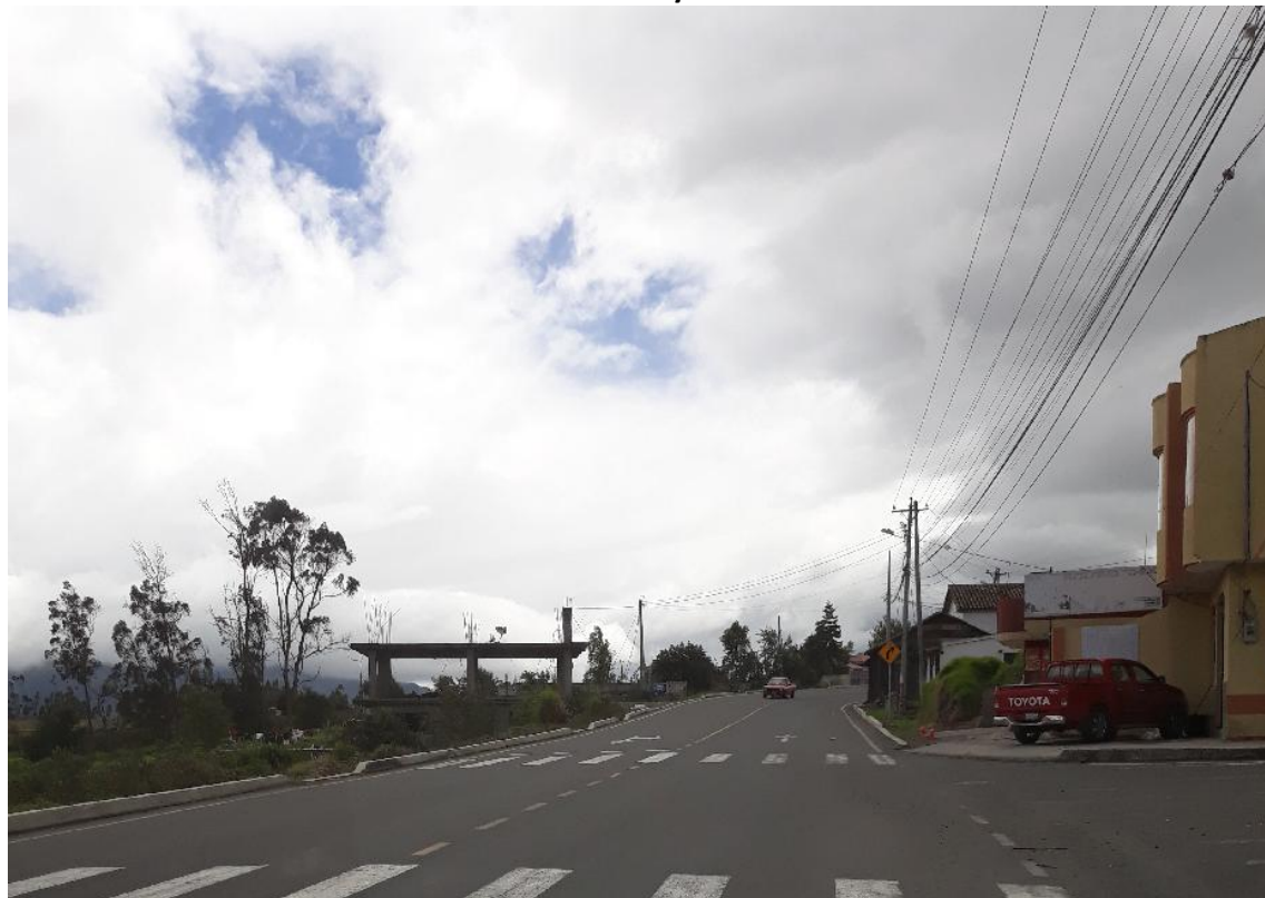
Foto 2 – Km 0+000 inicio de la ruta. Sector la Moya en Pelileo.
