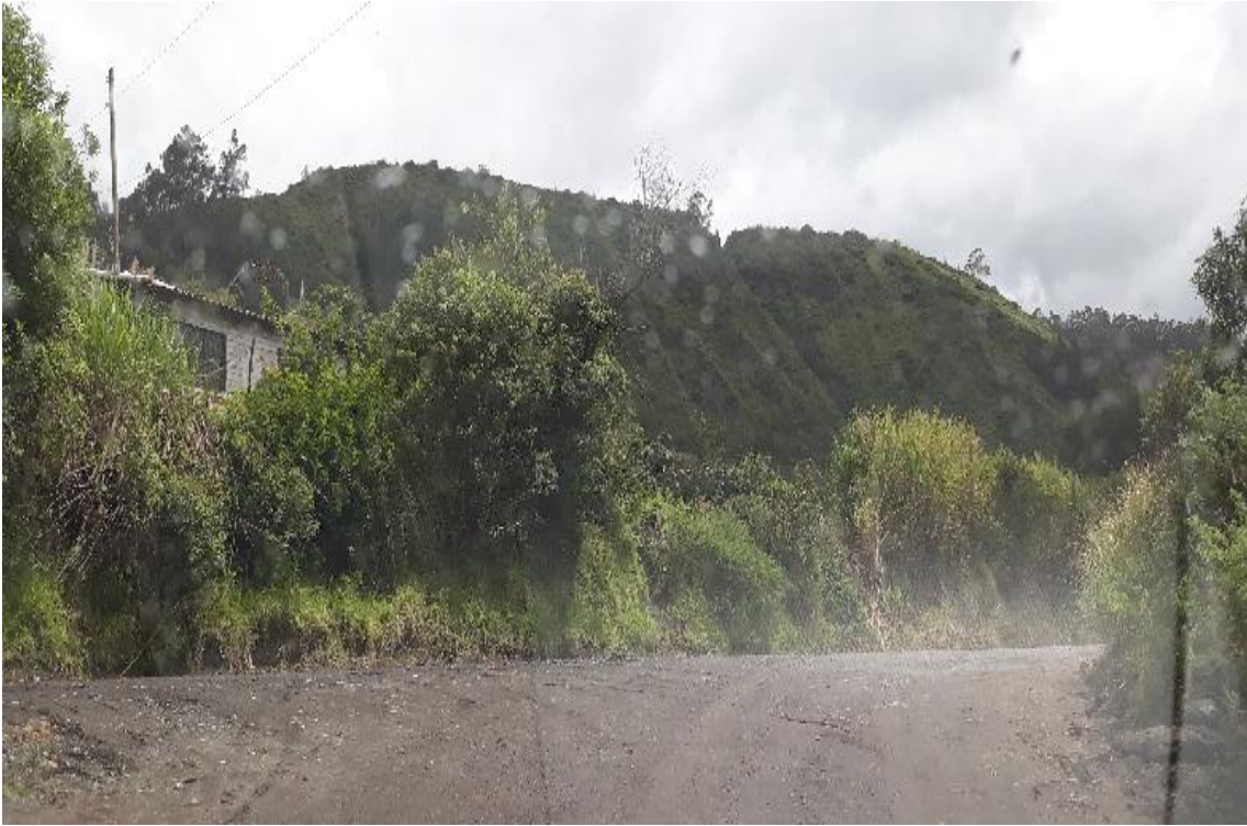
Foto 31 – Km 11+900 empalme del camino de desvío con vía antigua.
