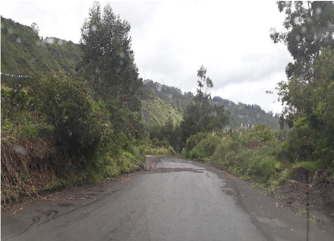
Foto 32 – Km 12+000 estado de vía antigua. Al fondo a la derecha otra vez un camino de desvío.
