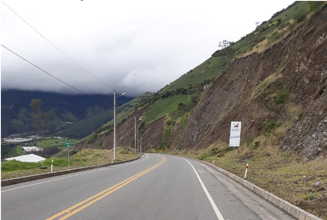
Foto 7 – Estado actual general de la vía.
