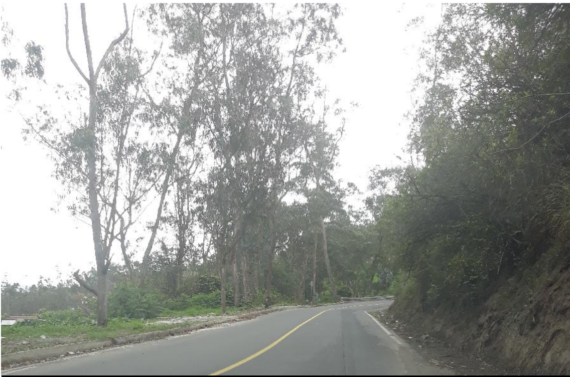
Foto 6 – Km 5+000 vista de sección transversal y estado actual de la vía.
