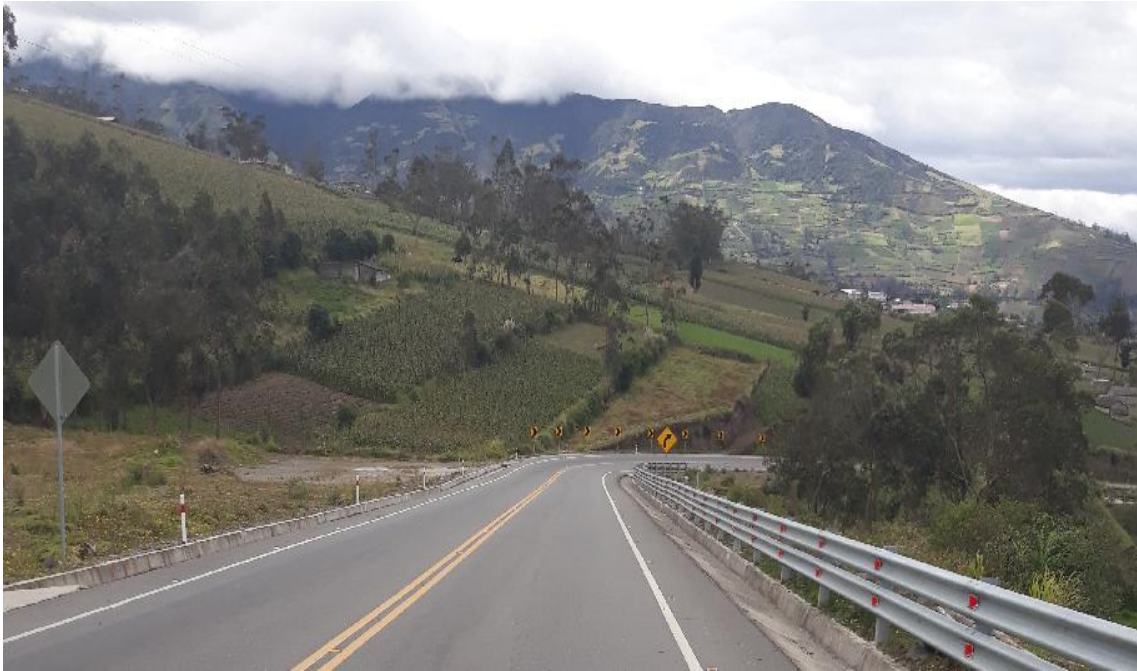
Foto 5 – Estado actual general de la vía. Vista hacia Pelileo.
