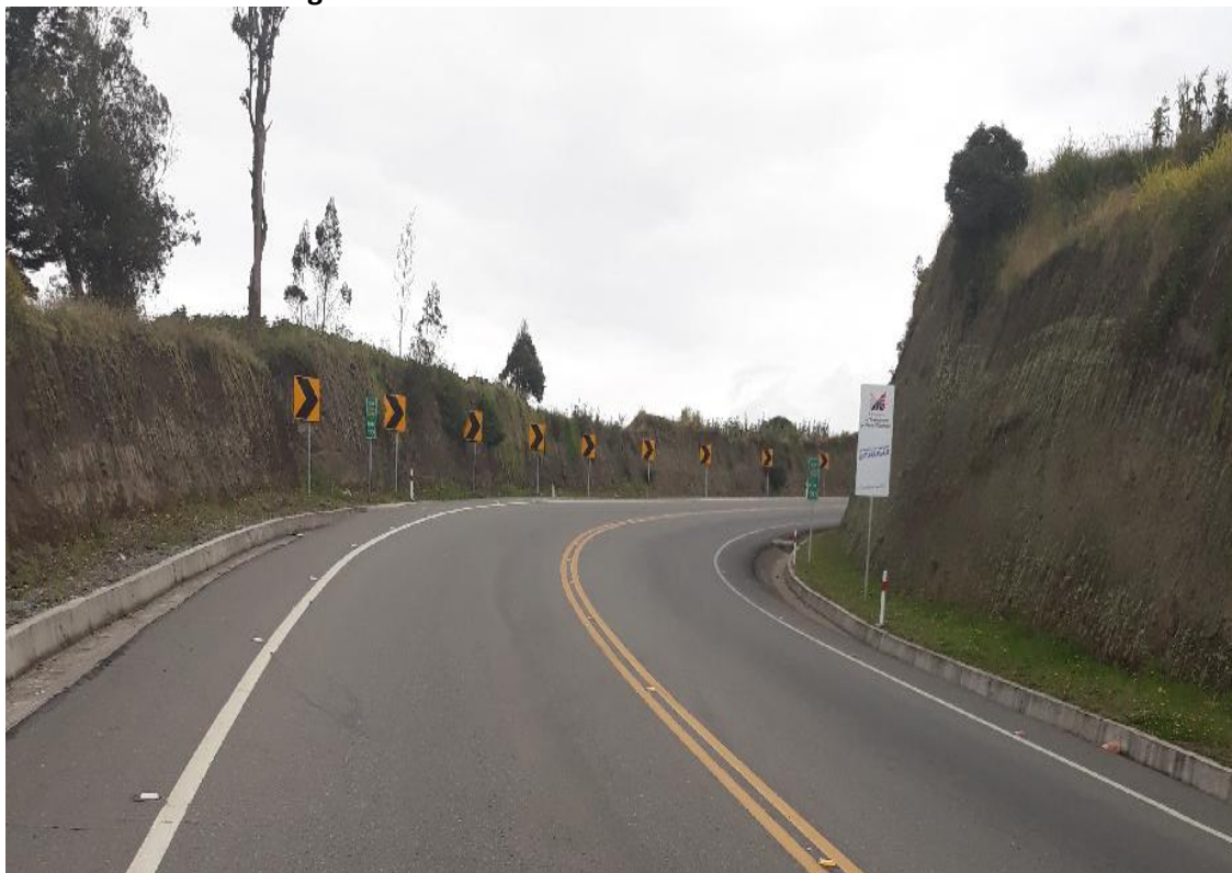
Foto 4 – Estado actual general de la vía.
