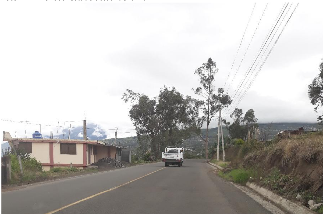
Foto 4 – Km 3+000 estado actual de la vía.
