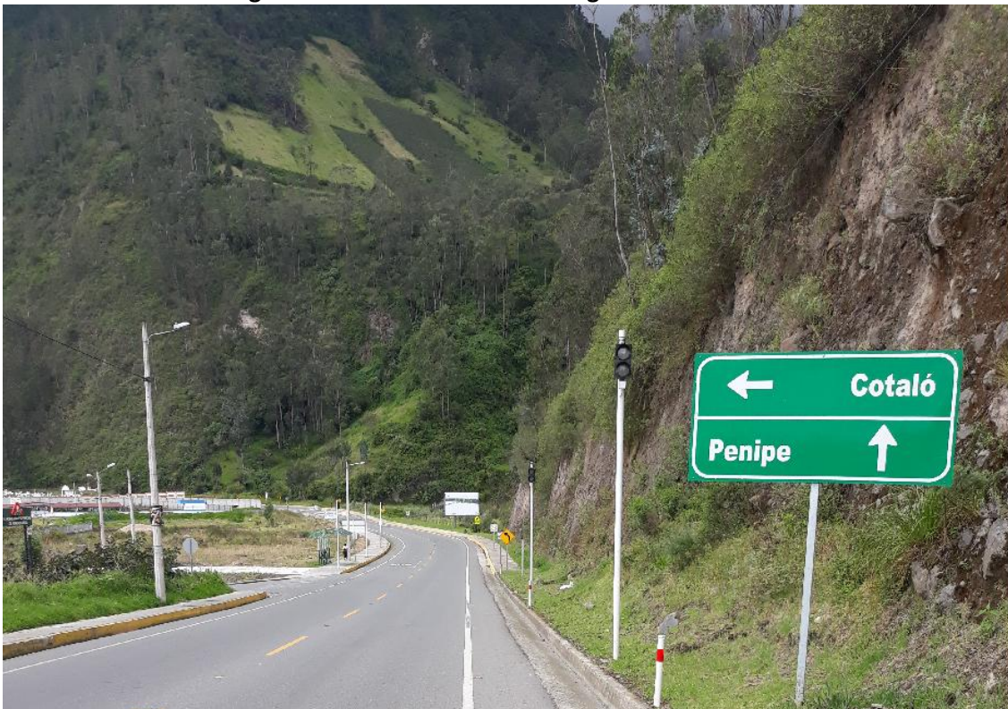
Foto 8 – Estado actual general de la vía. Km 12+800 ingreso a Cotaló.
