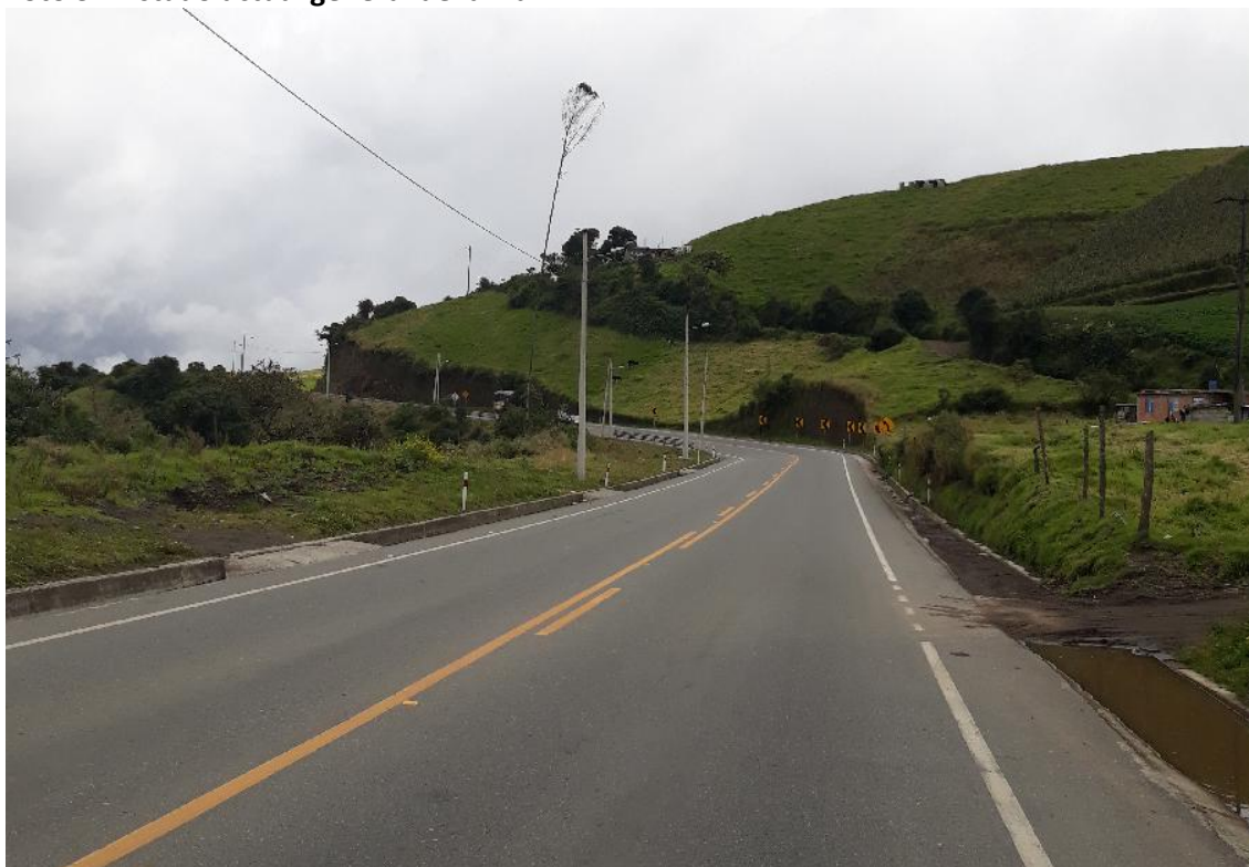
Foto 3 – Estado actual general de la vía.
