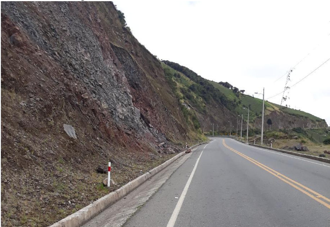
Foto 6 – Estado actual general de la vía. Vista hacia Pelileo.
