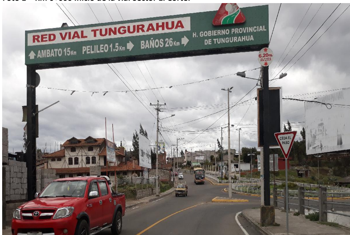
Foto 1 – Km 0+000 Inicio de la vía. Sector El Corte.
