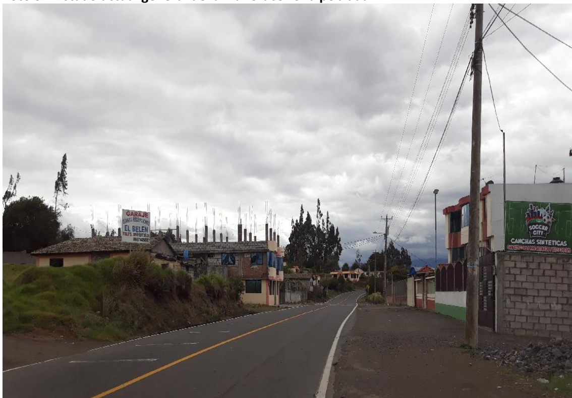
Foto 3 – Estado actual general de la vía. Cruce zona poblada.
