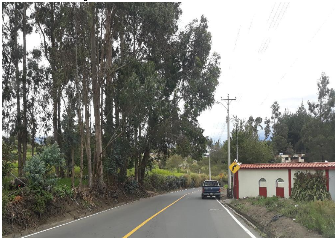
Foto 2 – Estado actual general de la vía.
