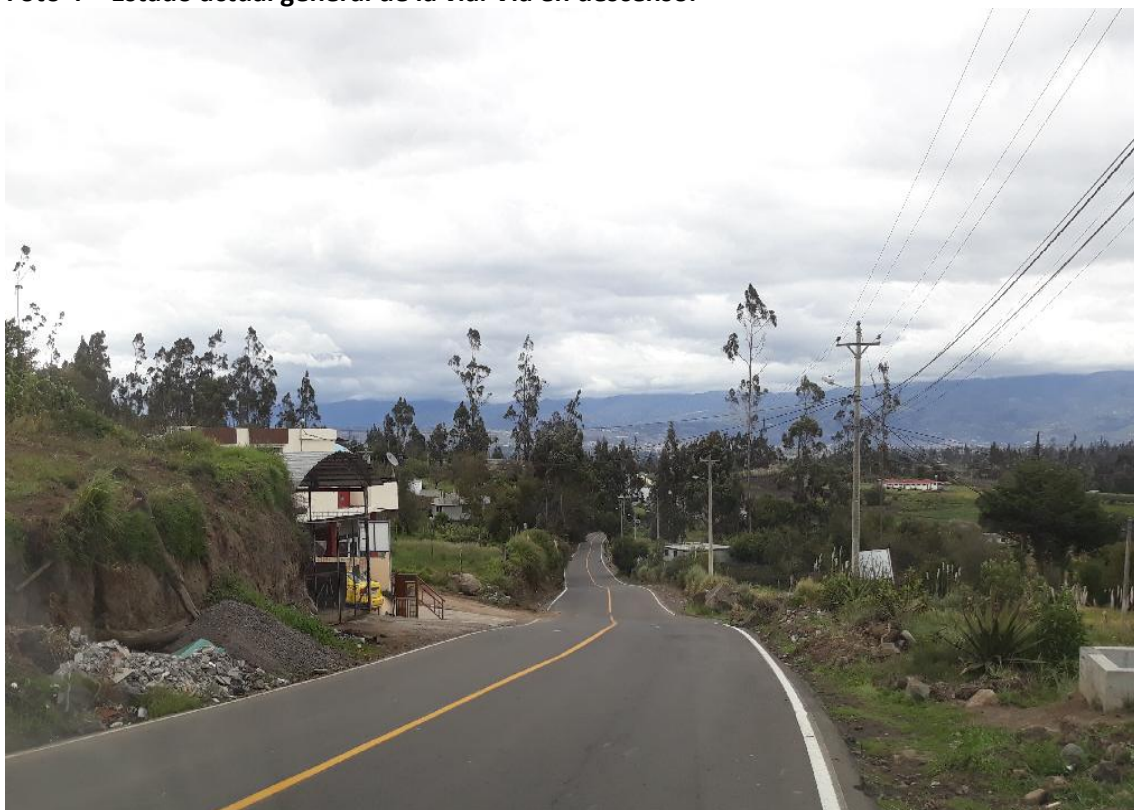
Foto 4 – Estado actual general de la vía. Vía en descenso.
