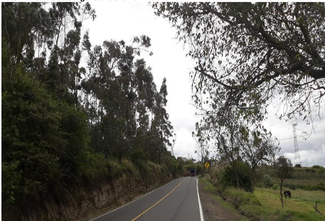
Foto 7 – Estado actual general de la vía.
