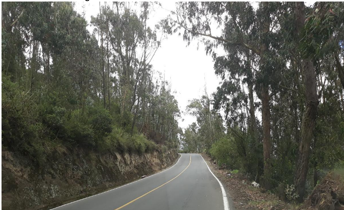
Foto 8 – Estado actual general de la vía.
