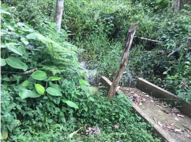
Alcantarilla colapsada considera para ser reemplazada.
