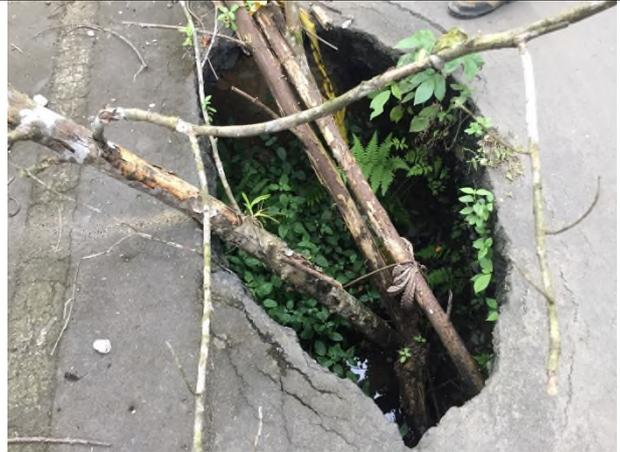
Hundimiento en la calzada producto de la falla del drenaje alcantarilla destruida, se produce asentamiento y socavación.
