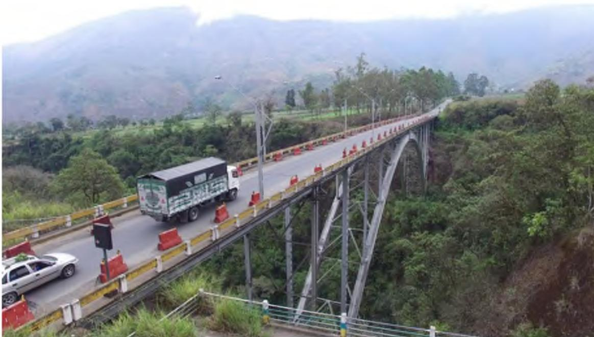
La alternativa presentada considero una estructura principal formada por un arco de hormigón armado de 135 metros de longitud entre apoyos, que sirve como apoyo de una estructura superior de 200 metros de longitud. Los principales aspectos considerados para este tipo de estructuración fueron los siguientes:
