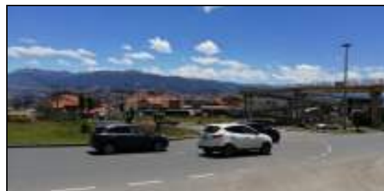
Vista lateral del redondel de Gapal, paso peatonal
