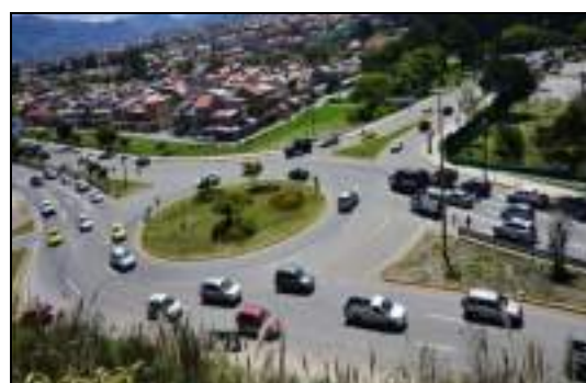
Vista general actual de la autopista y redondeL, vistos desde el frente del Hospital del IESS
