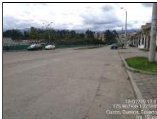
Ingreso Hospital y Urbanización
