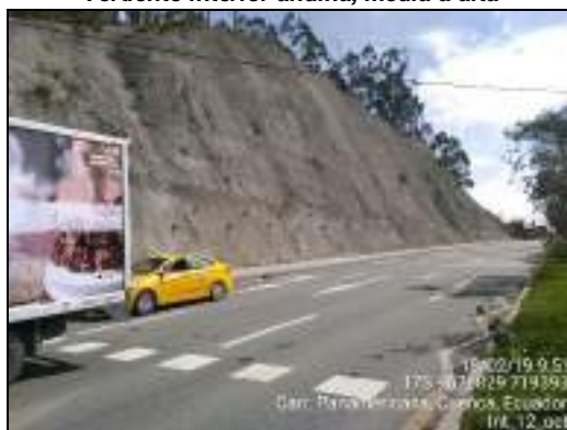
Talud Margen Derecho Autopista
