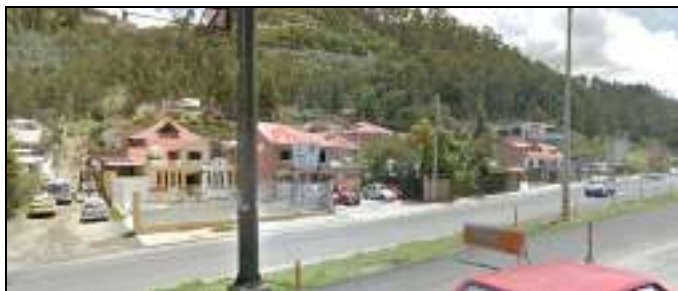
Vista general viviendas
