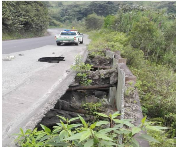
Muro provisional de planchas metálicas.
