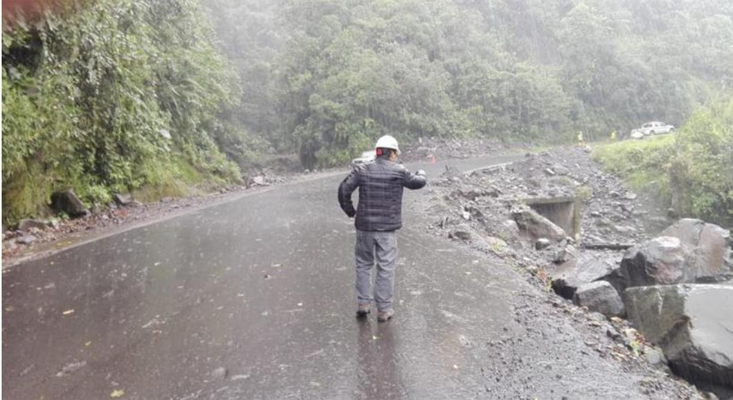
Alcantarilla doble de hormigón, con material sedimentado lo que hace que pierda sección hidráulica.
