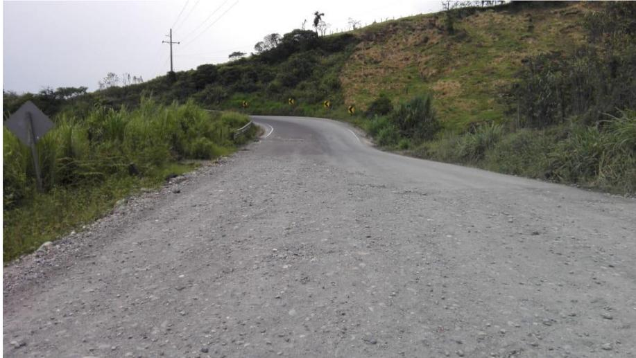
Deformación de la calzada por afloración de agua
