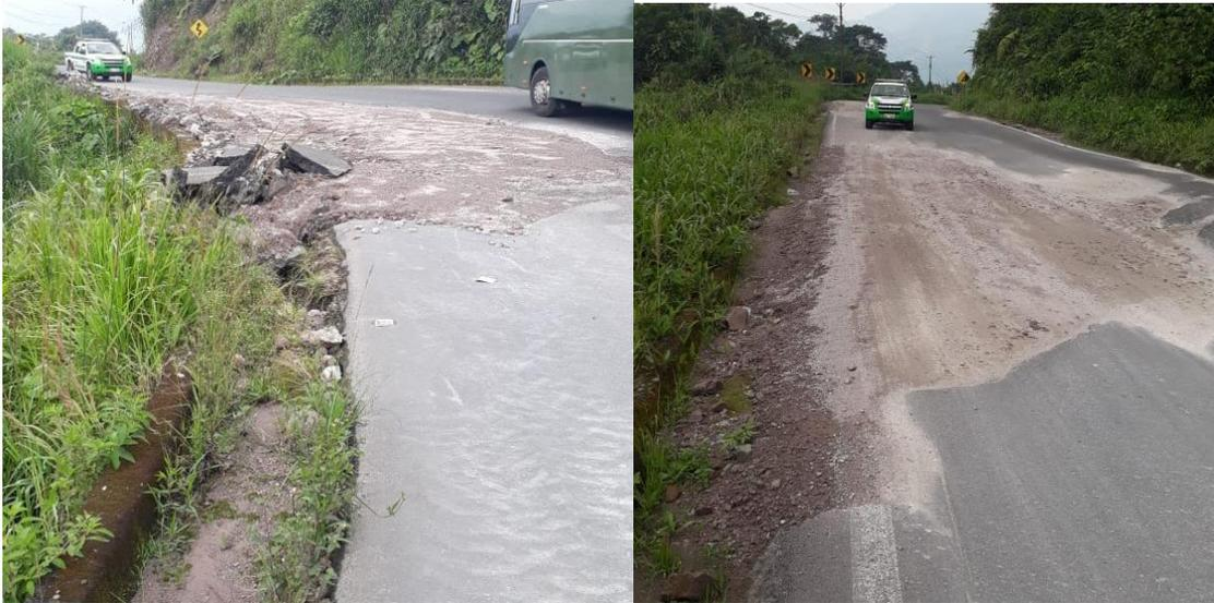
Desplazamiento y asentamiento, afectación en la calzada
