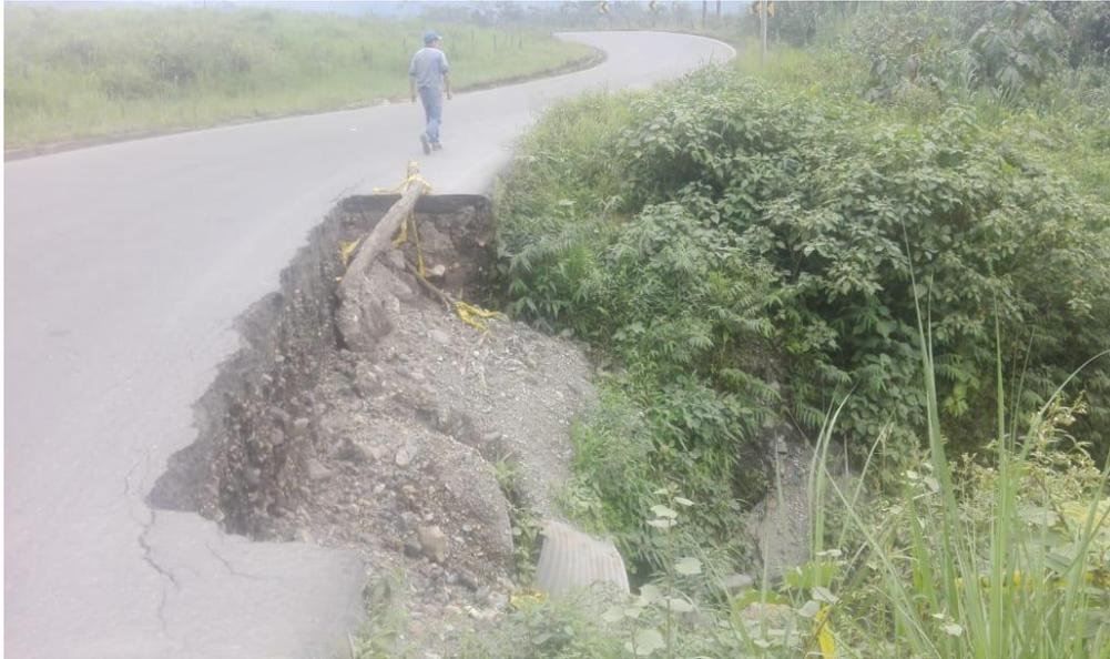
Deslizamiento de talud inferior, daños en la calzada. Falla en media luna por asentamiento
