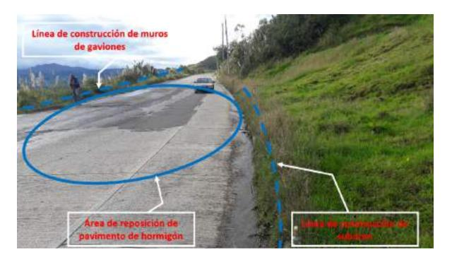
Deslizamiento del talud del terraplén en el lado izquierdo de la vía a causa de la falta de cunetas para la conducción de aguas lluvias hacia las alcantarillas en este sector.
