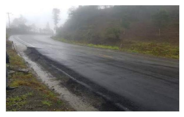
Asentamiento de la mesa del terraplén en todo el ancho de la vía debido a filtraciones de aguas lluvias por la capa de subbase granular que ocasiona la migración de finos y el asentamiento del terraplén. En la inspección realizada el viernes 17 de enero del 2020, se pudo observar que un drenaje natural atraviesa transversalmente la carretera, en el mismo sentido del asentamiento del terraplén, que podría ser la causa de este problema.
