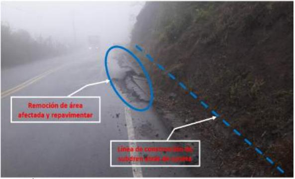
Deslizamiento de material fino del corte del talud sobre la calzada en el lado izquierdo de la vía. En la inspección realizada se pudo observar que la cuneta en el lado izquierdo de la vía se encuentra fracturada y levantada sobre el nivel de la calzada, permitiendo el ingreso de las aguas lluvias a la estructura del pavimento.
