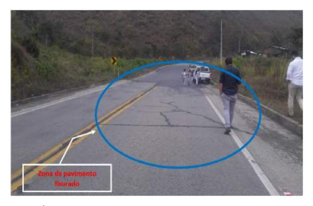
Asentamiento de la mesa del terraplén en todo el ancho de la vía debido a filtraciones de aguas lluvias por la capa de subbase. En la primera inspección realizada se pudo observar la separación longitudinal de los paños de pavimento hasta un máximo de 10 cm, en una longitud aproximada de 80 m. En la segunda inspección realizada el viernes 17 de enero del 2020, se pudo observar que existen problemas de drenaje en el lado izquierdo de la vía.
