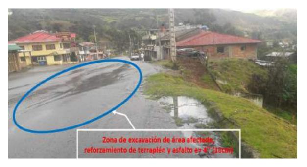
Asentamiento de la mesa del terraplén en el lado izquierdo de la vía debido a la acumulación de aguas lluvias sobre la calzada y deslizamiento del terraplén.
