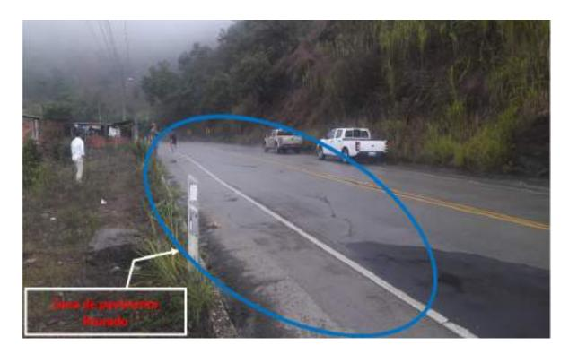
Asentamiento de la mesa del terraplén en el carril derecho de la vía, debido a filtraciones de aguas lluvias por la capa de subbase granular que ocasiona la migración de finos y el asentamiento del terraplén. En la inspección realizada el viernes 17 de enero del 2020 se pudo observar que existe un muro de contención de este lado de la vía que no presenta fractura ni deslizamiento. SOLUCIÓN RECOMENDADA:
