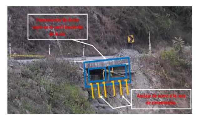
Socavación del terraplén de la vía bajo la losa del pavimento en el carril izquierdo de la vía, debido a filtraciones de aguas lluvias por la capa de subbase. En la inspección realizada se pudo observar que la reparación de este punto debe realizarse con el carácter de urgente a fin de no interrumpir el tráfico en este sector por un colapso de la vía.
