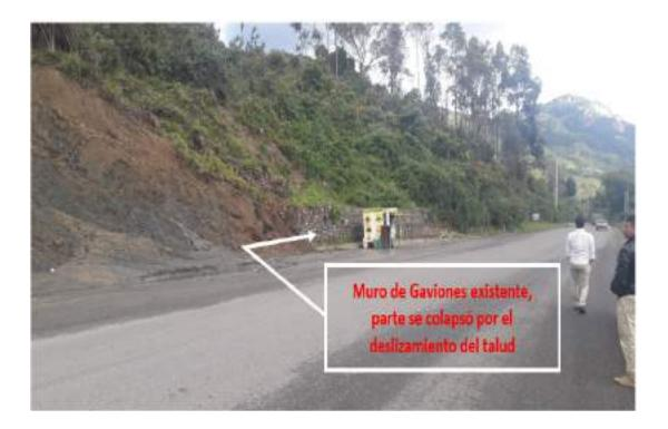
Deslizamiento del talud en el lado derecho de la vía, talud inestable, material plomo, en la parte alta del talud existen unas lagunas cuyas filtraciones podrían ser la causa del deslizamiento del talud.
