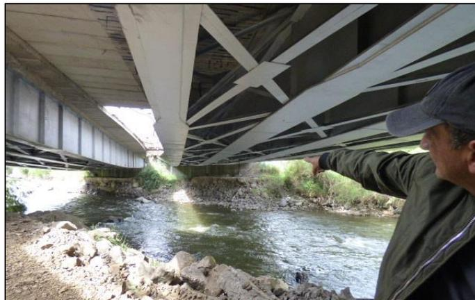
Gráfico 17 Deformaciones en superestructura de Puentes sobre el río Cuenca
