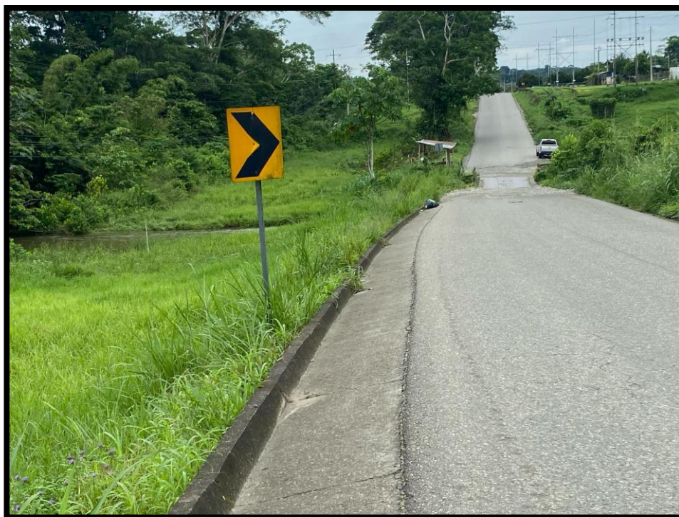
Ilustración 2. Cobertura vegetal puente La Norte
